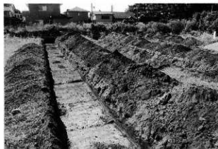
調査トレンチ
