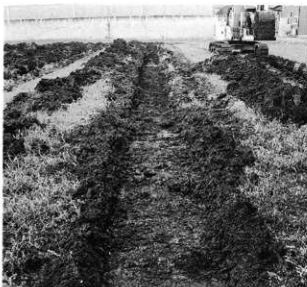
調査トレンチ
