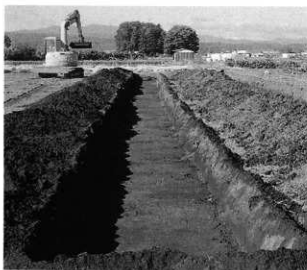
調査トレンチ
