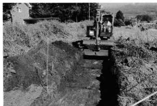
調査トレンチ
