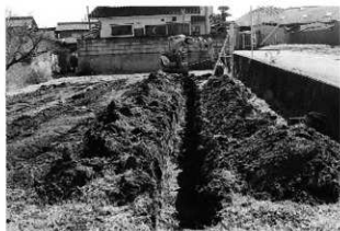
調査トレンチ
