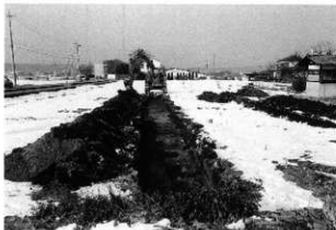
調査トレンチ
