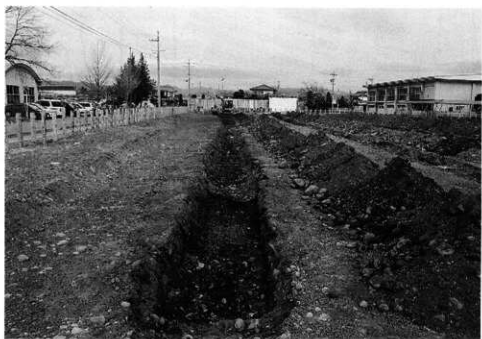
調査トレンチ
