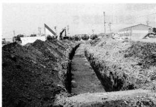
調査トレンチ
