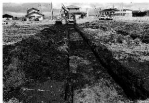
調査トレンチ
