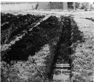
調査トレンチ
