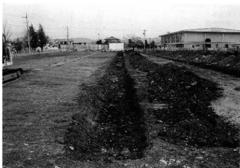
調査トレンチ
