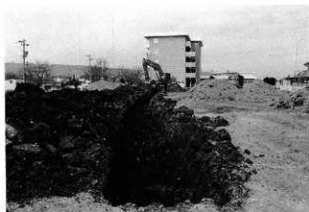
調査トレンチ
