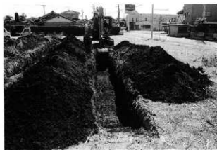
調査トレンチ
