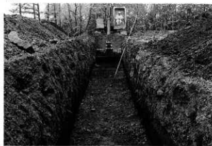
調査トレンチ
