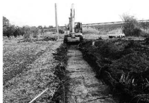
調査トレンチ
