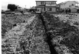
調査トレンチ
