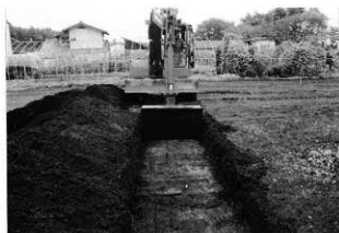
調査トレンチ
