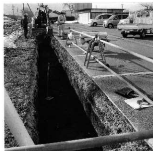
調査トレンチ
