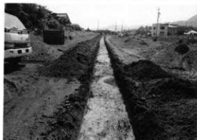
試掘トレンチ
