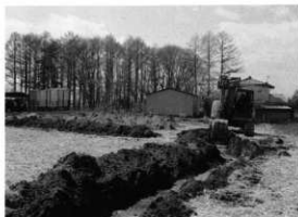
試掘トレンチ
