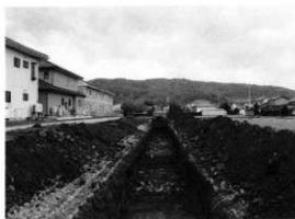
試掘トレンチ
