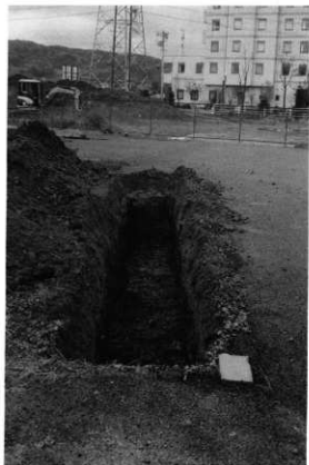
試掘トレンチ
