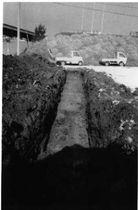
試掘トレンチ
