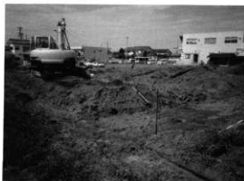
試掘トレンチと遺構
