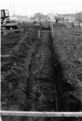
掘削・堆積状態
