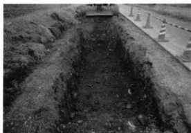
試掘トレンチ
