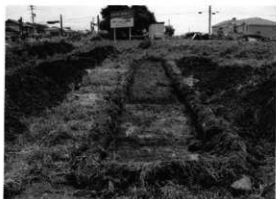
試掘トレンチ
