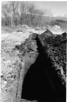
試掘トレンチ
