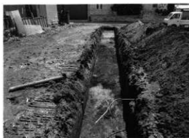
試掘トレンチ
