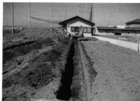
試掘トレンチと遺構
