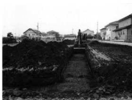
試掘トレンチと遺構
