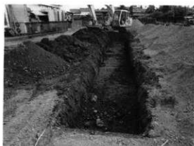
試掘トレンチと遺構
