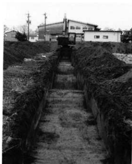
試掘トレンチ
