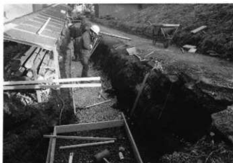
掘削・堆積状況
