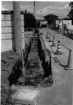
掘削・堆積状況
