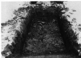
試掘トレンチ
