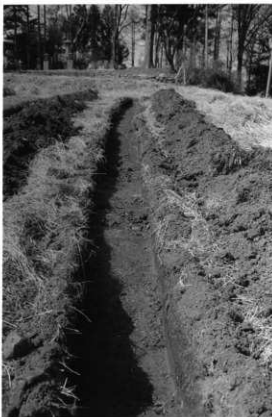
試掘トレンチ
