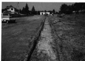
試掘トレンチ
