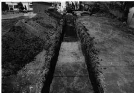
試掘トレンチ
