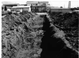
試掘トレンチ
