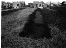
試掘トレンチ
