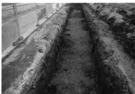
試掘トレンチ
