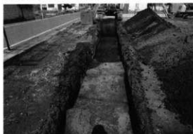
試掘トレンチ
