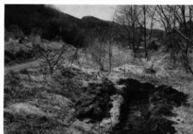
試掘トレンチ
