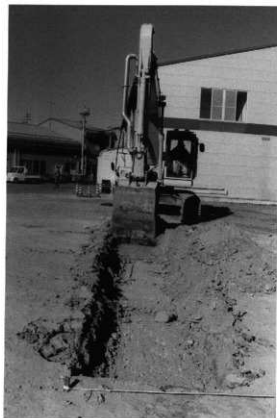
試掘トレンチ
