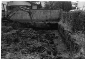
掘削・堆積状況
