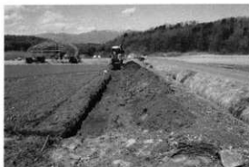
試掘トレンチ
