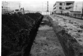
試掘トレンチ
