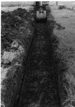
試掘トレンチ
