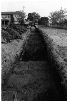
試掘トレンチ
