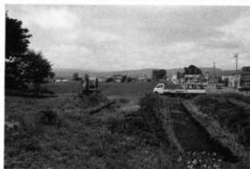
試掘トレンチ
