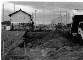
工事立会状況
