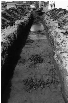
試掘トレンチと遺構
