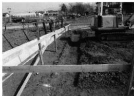
掘削・堆積状態
