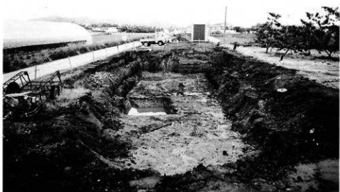
調査東区東側全景 西より
