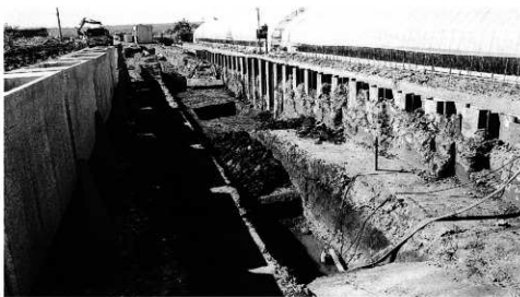
調査東区北側 調査状況 東より
