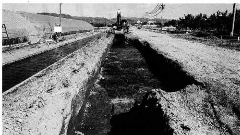
調査東区北側掘削状況 西方より
