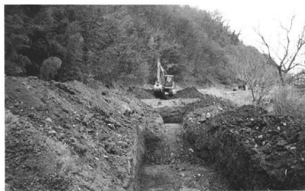
完掘状況 南より
