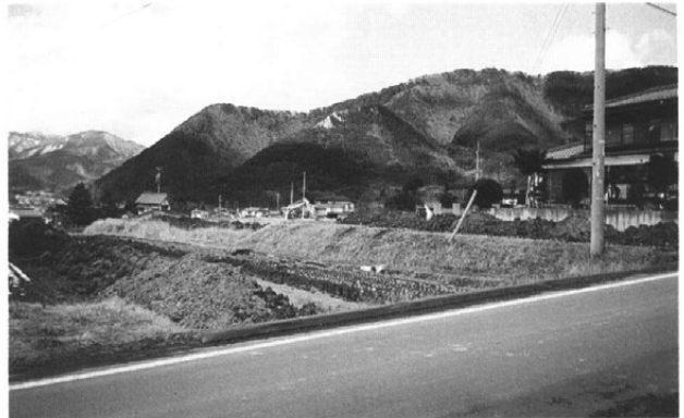
トレンチ完掘状況 南東より
