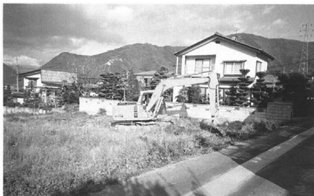
1号トレンチ掘削状況 南東より
