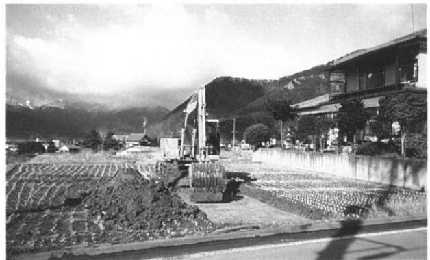
2号トレンチ掘削状況 東より
