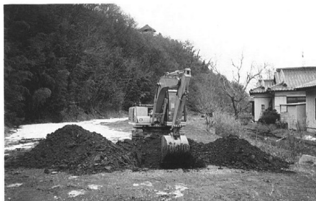
TP1 掘削状況 南より
