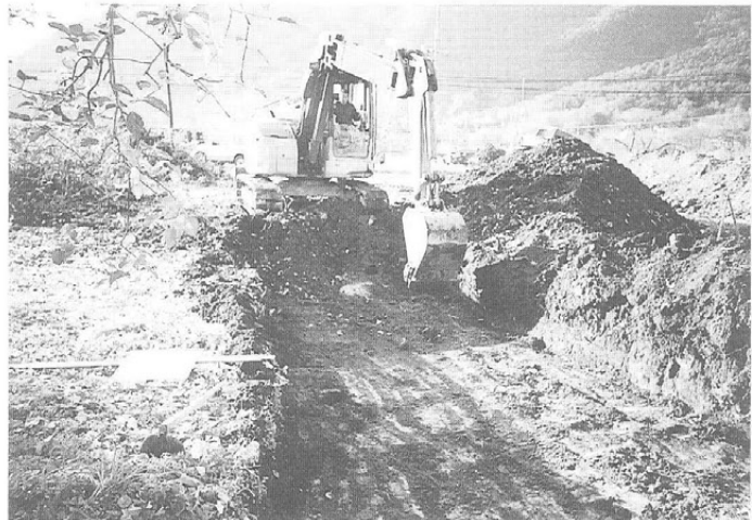
2号トレンチ掘削状況 (東より)
