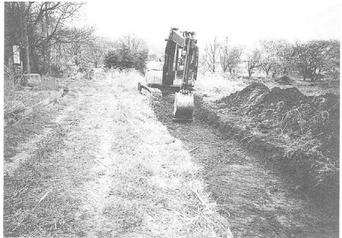
1号トレンチ掘削状況 (北より)
