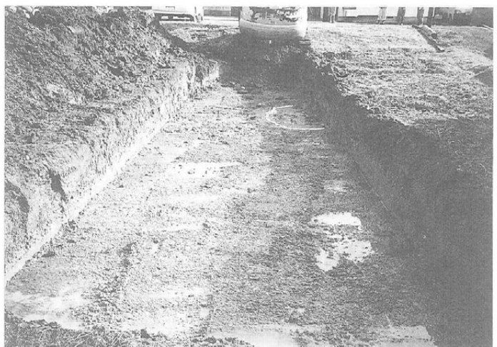
トレンチ検出状況 (西より)
