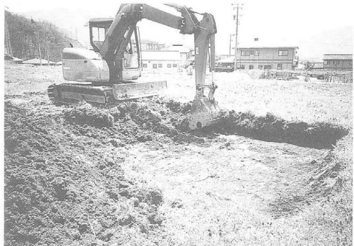
1号トレンチ検出状況 (北東より)
