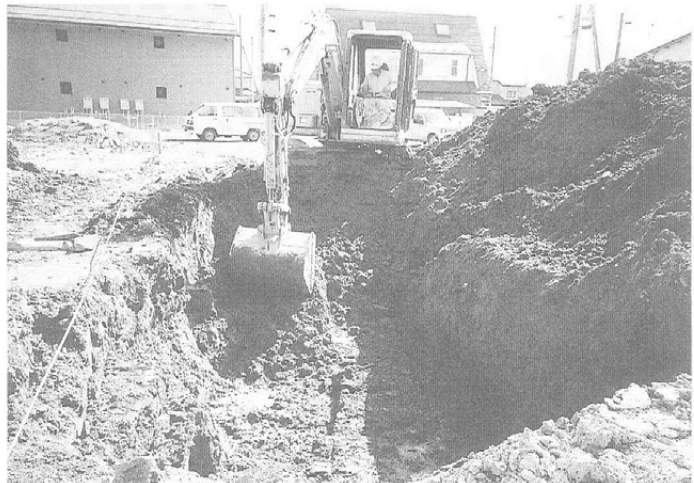
トレンチ掘削状況（北より）
