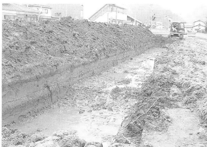
トレンチ検出状況 (東より)
