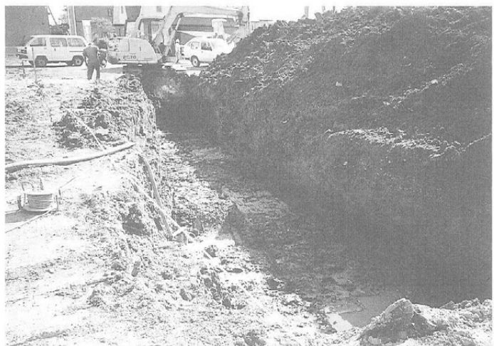
トレンチ検出状況（南より）
