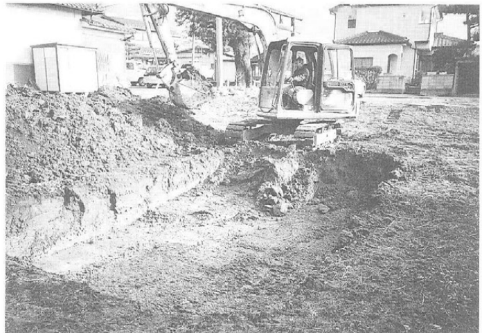
トレンチ掘削状況 (西より)
