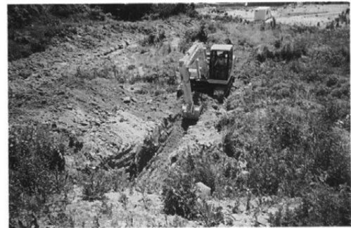
2号トレンチ調査状況（東より）
