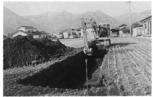
1号トレンチ調査状況（東より）
