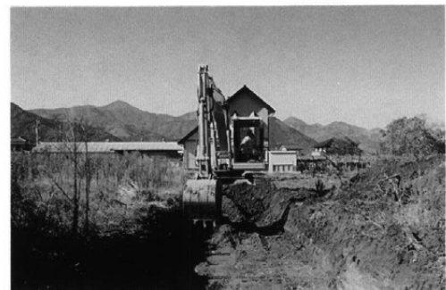
2号トレンチ調査状況 (東より)
