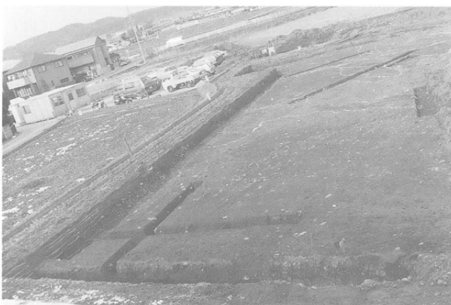
A地区第1面全景（南から）
