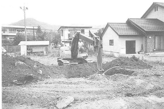
1号トレンチ掘削状況 (東より)
