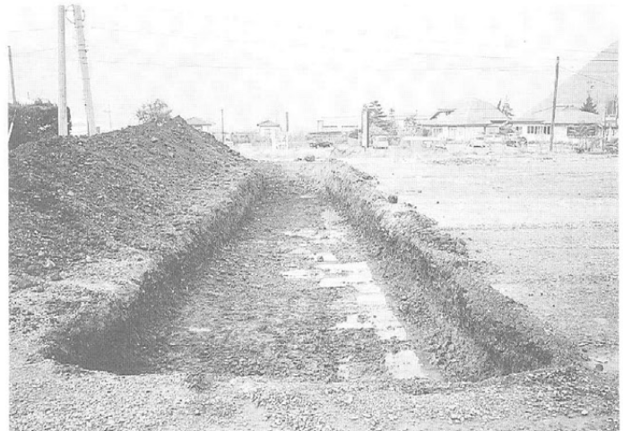
1号トレンチ掘削状況 (東より)
