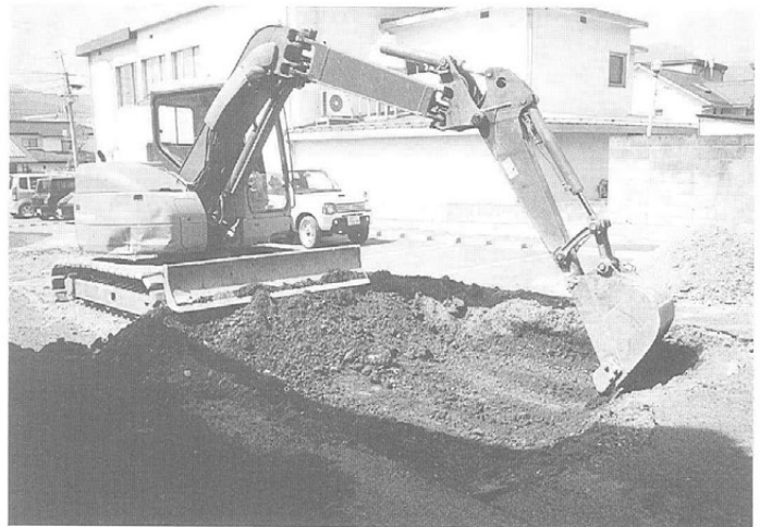
トレンチ掘削状況 (東より)
