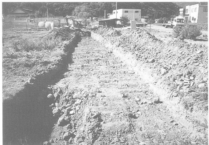
1号トレンチ掘削状況 (東より)
