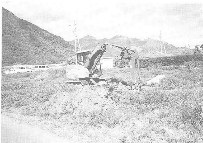
トレンチ掘削状況 (南東より)
