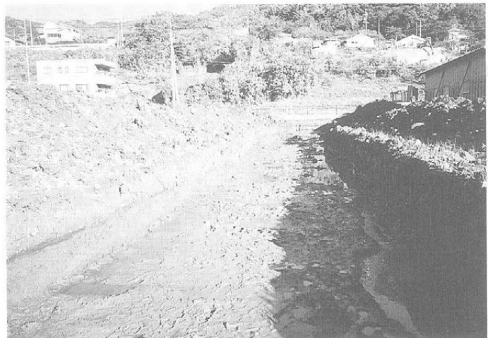
トレンチ検出状況 (西より)
