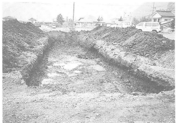
2号トレンチ作業状況 (東より)
