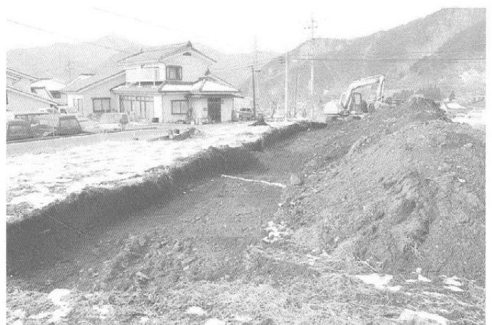
トレンチ検出状況 (北東より)
