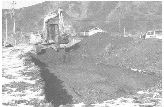
掘削状況 (東より)
