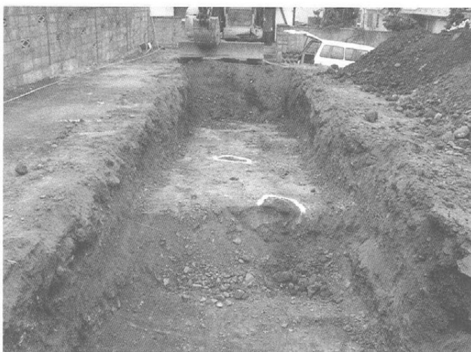
トレンチ検出状況 (東より)
