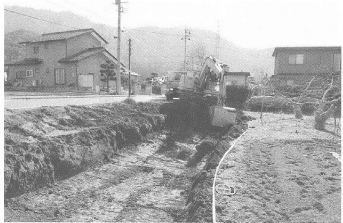
トレンチ掘削状況 (東より)
