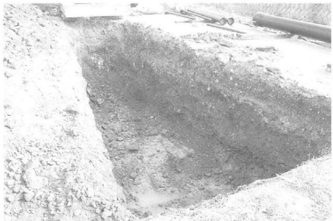
トレンチ検出状況 (南西より)
