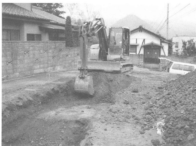
トレンチ掘削状況 (東より)
