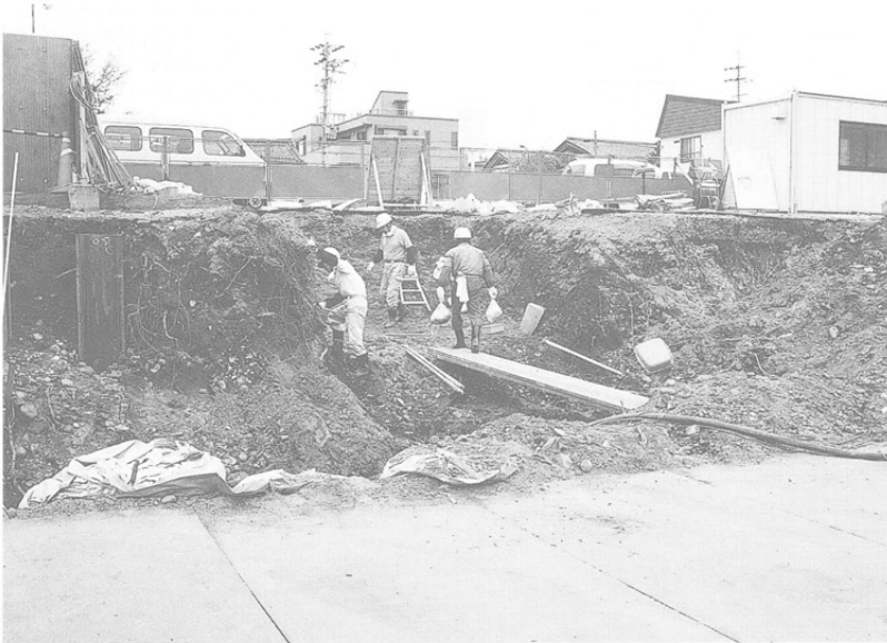
第2次調査 作業状況
