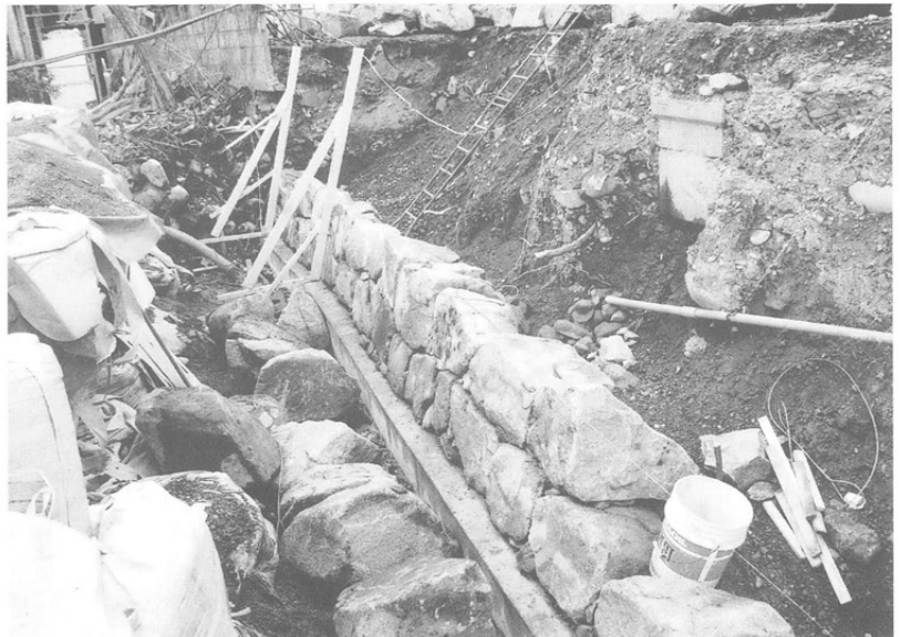
石積み状況(南端部)
