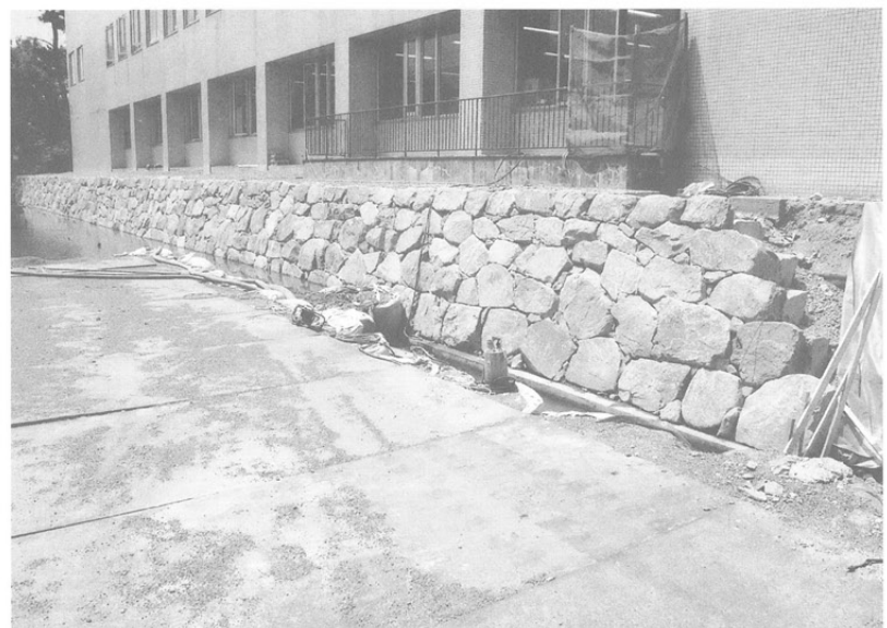
15年度分の石積み完了状況
