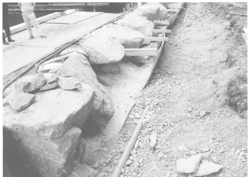
同上 (裏込めコンクリートの状況)
