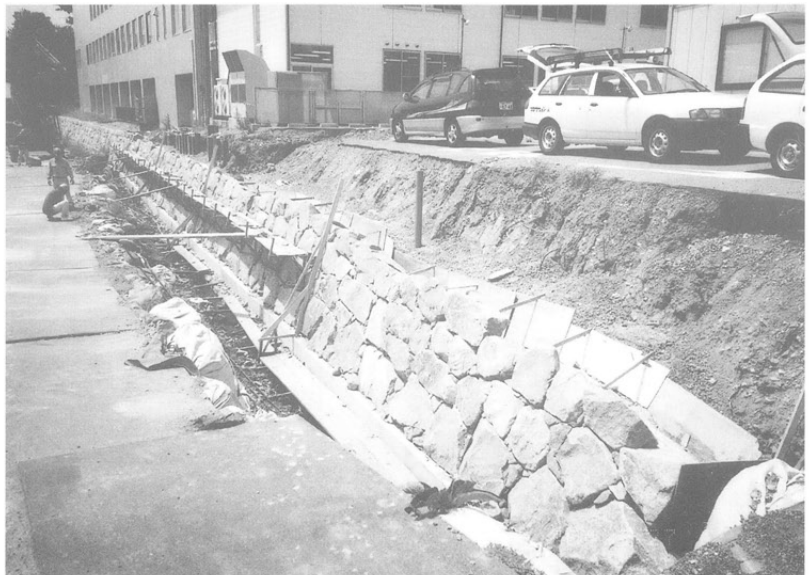
石積み状況 (折点より北側)
