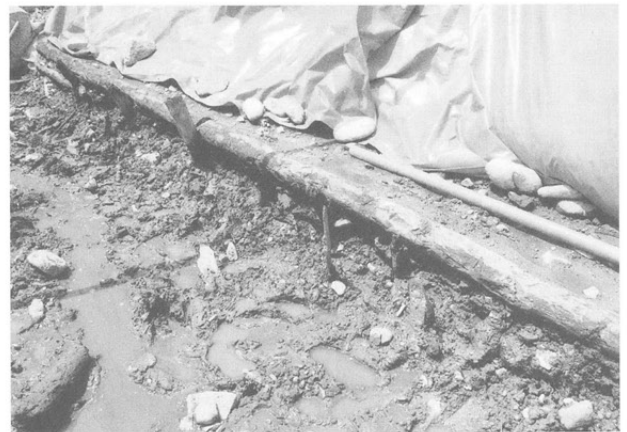
枕胴木と止杭の状況。(基準番号14付近)
