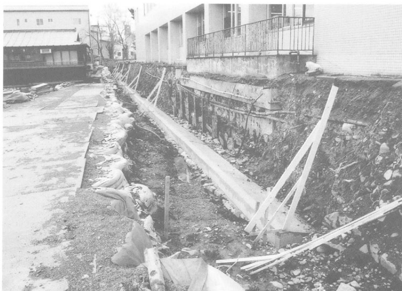
コンクリート布基礎打設状況
