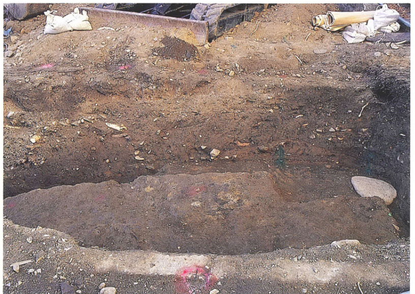
第1次調査 (T1南壁面)
