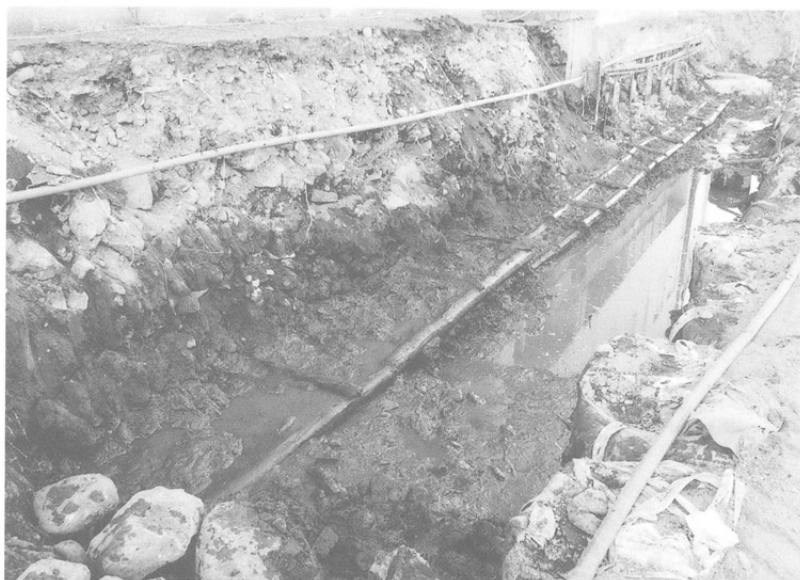
既存石垣解体後の状況 (基礎胴木が見えている)
