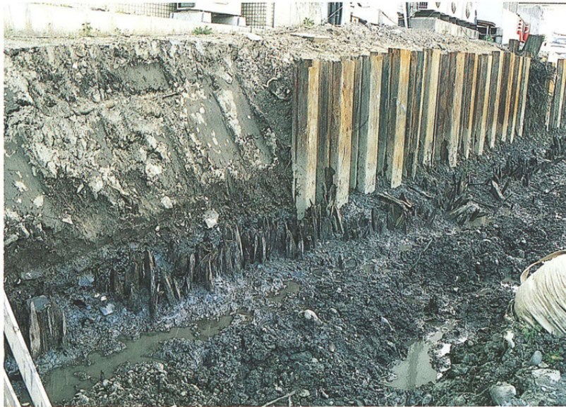
第2次調査 (杭列・南側より)
