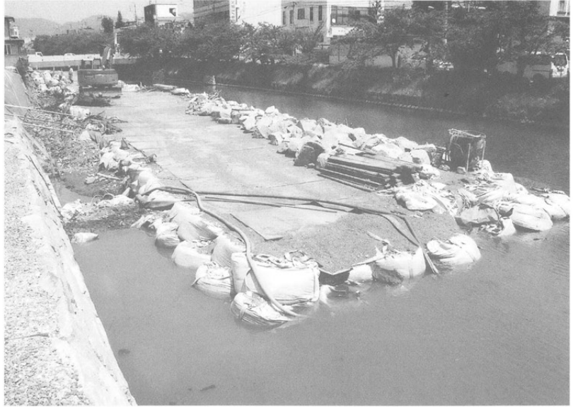
仮説通路短縮状況
