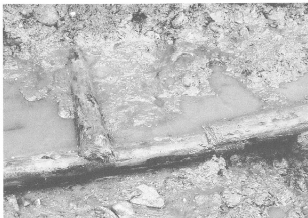
枕胴木と控木の状況。継手は相欠き(基準番号8付近)
