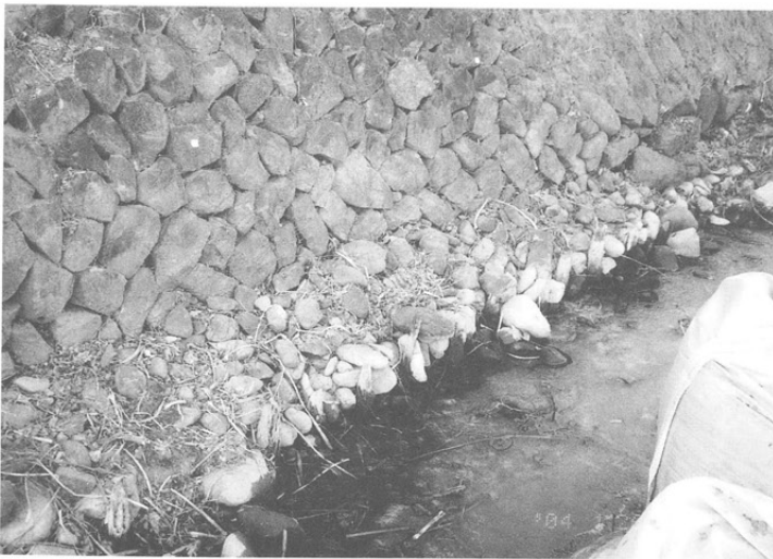
石垣脚部の補強工（基準番号15～16付近）
