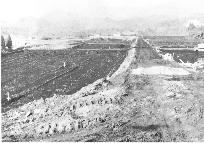
新村遺跡遠景（東から）
