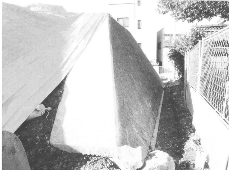
北側擁壁完了(東から)
