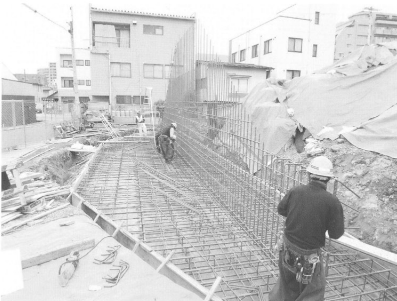
南側擁壁配筋 立上り部分の配筋施工
