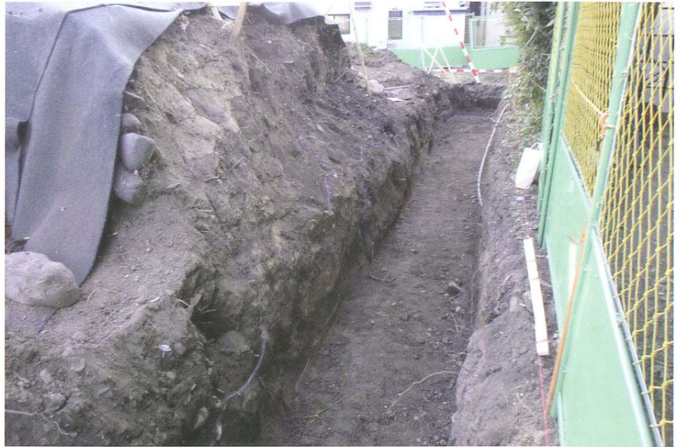
北側擁壁掘削立会い調査 土塁北側残存状況(東から)
