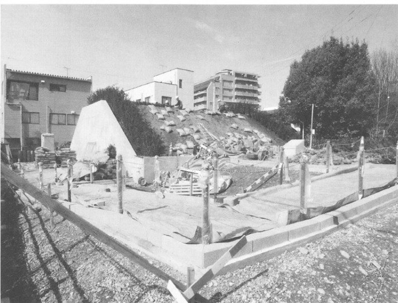
広場東南隅から全体 手前がスロープの施工中 奥に植栽中の土塁が見える
