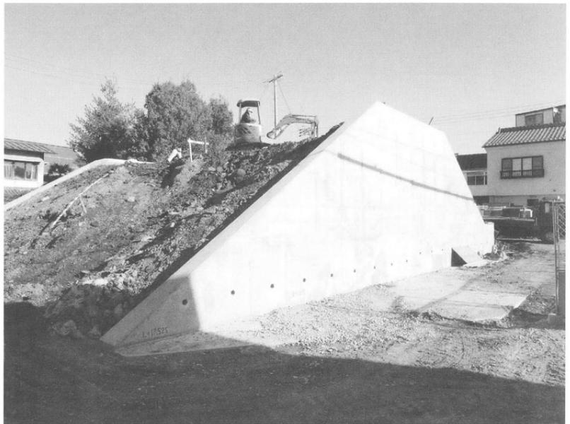
南側擁壁コンクリート打設完了
