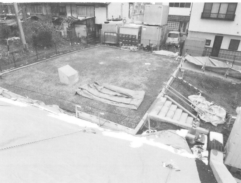
武家屋敷跡整備施工中
