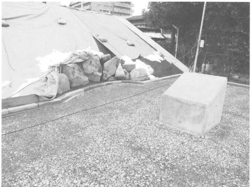
池状遺構挟り込み部の擁壁完了 地盤はカラー舗装の路床となる 碎石敷で、武家屋敷跡説明板躯体 はそこに置いた状態で据える
