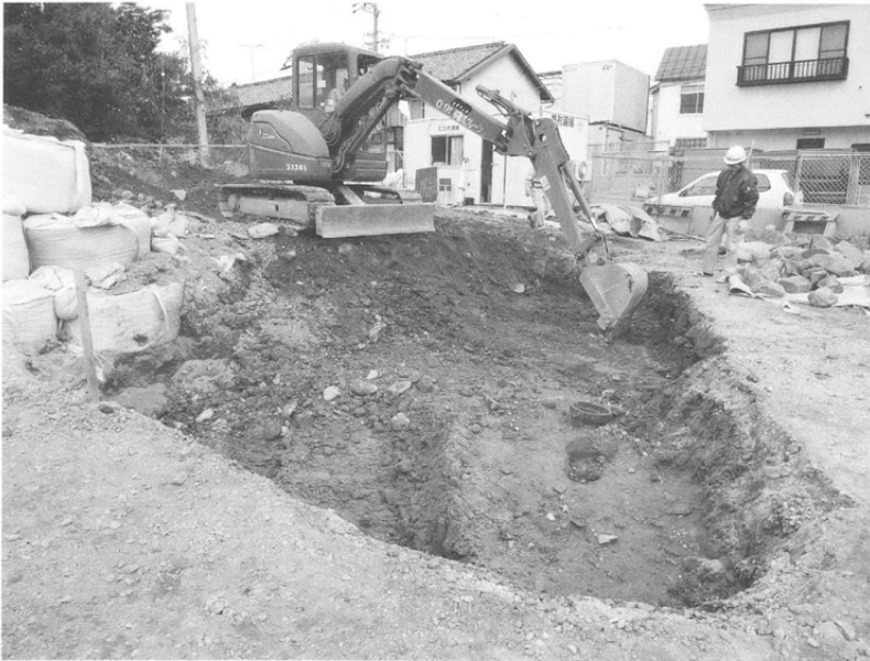
南側擁壁基礎部掘削
