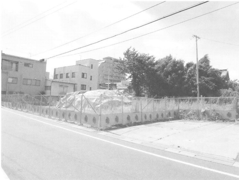
着手前 現場全景・遺構養生
