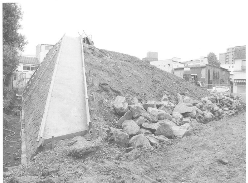
北側擁壁の造成
