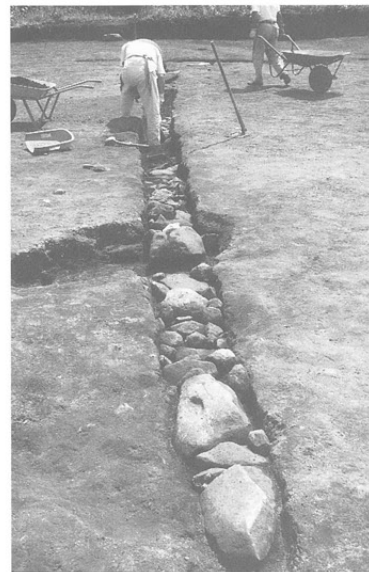
集水遺構 1 調査状況
