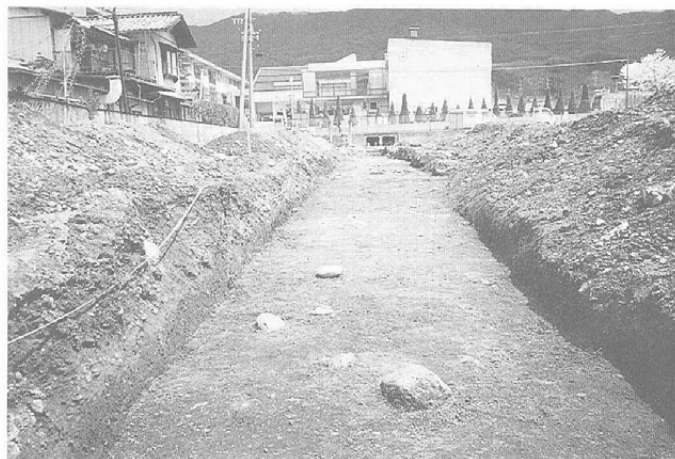
1号トレンチ完掘状況(東より)
