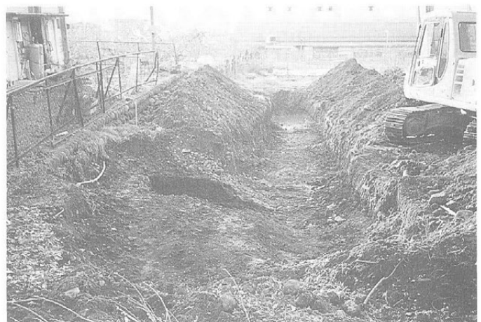
2号トレンチ完掘状況(東より)
