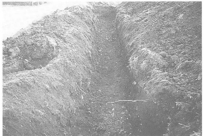
1号トレンチ完掘状況(東より)
