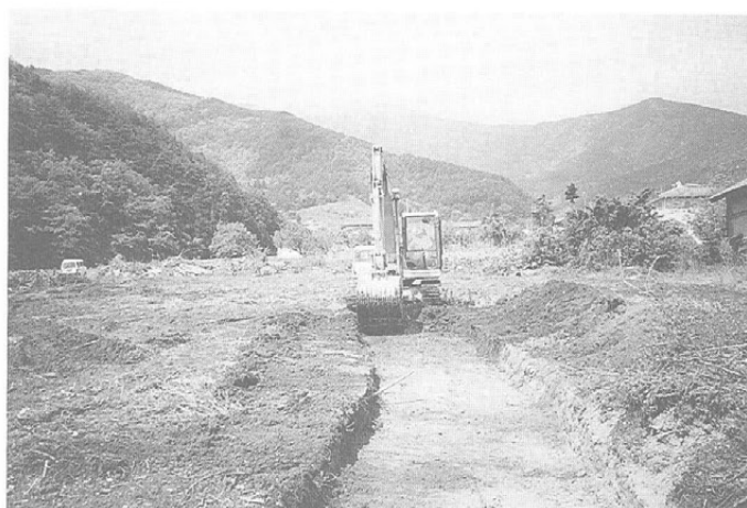
トレンチ掘削状況(東より)
