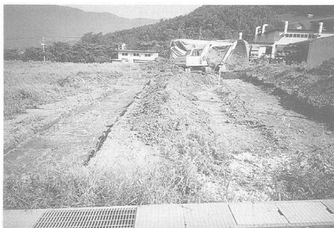
1号トレンチ掘削状況(南より)
