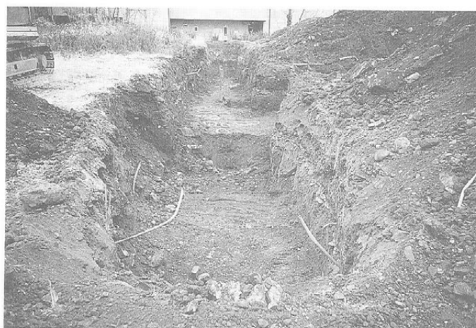
1号トレンチ完掘状況(北より)
