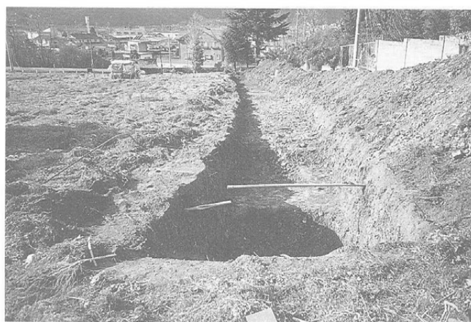
1号トレンチ完掘状況(東より)
