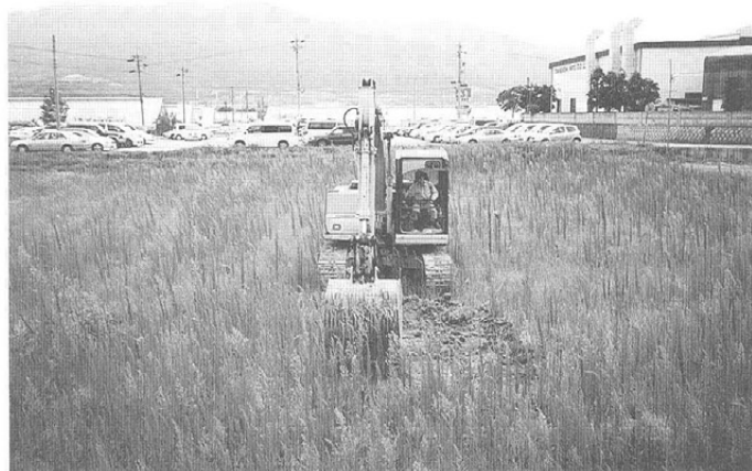
トレンチ掘削状況 (西より)
