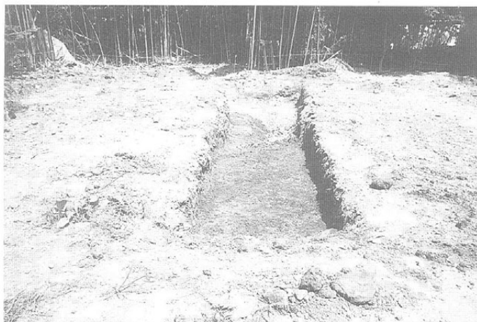
2号トレンチ検出状況(西より)
