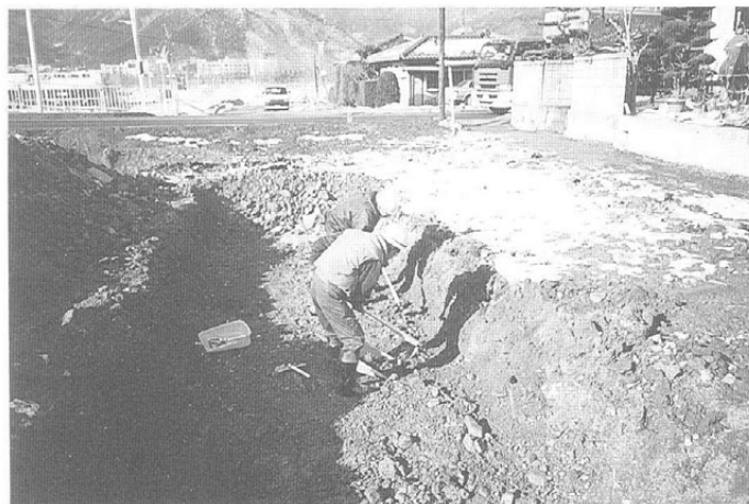
1号トレンチ作業状況 (東より)
