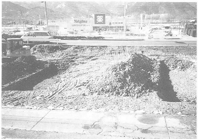
トレンチ完掘状況（東より）
