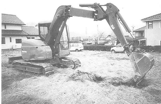
トレンチ掘削状況 (北東より)
