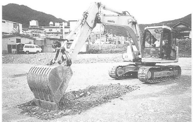
トレンチ掘削状況 (東より)
