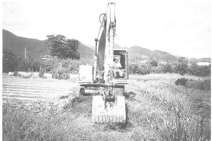
トレンチ掘削状況 (東より)
