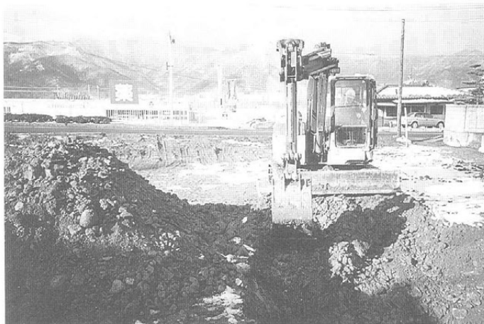
1号トレンチ掘削状況1 (東より)
