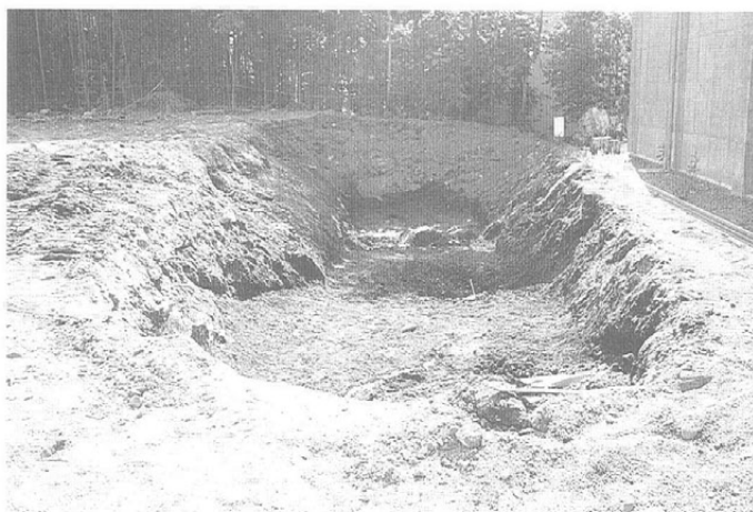
1号トレンチ検出状況(西より)
