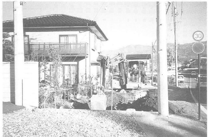
トレンチ掘削状況 (南より)
