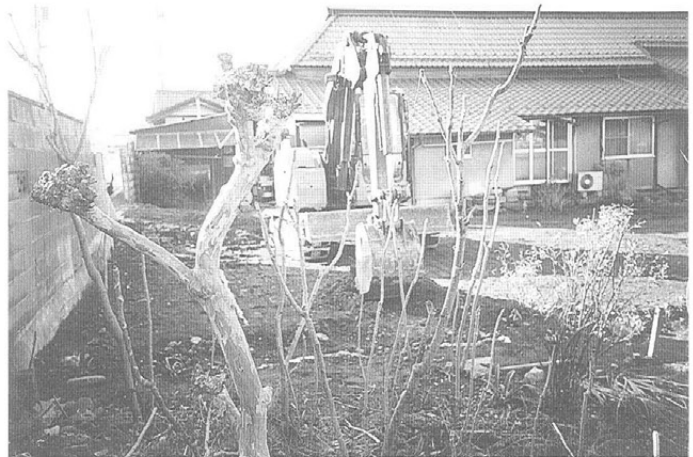
トレンチ掘削状況 (北より)
