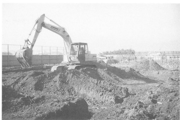
重機による作業
