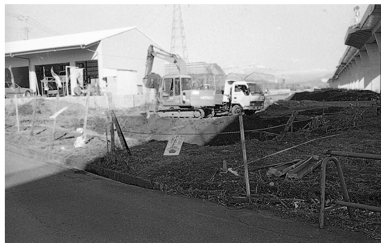
写真1 表土剥ぎ風景
