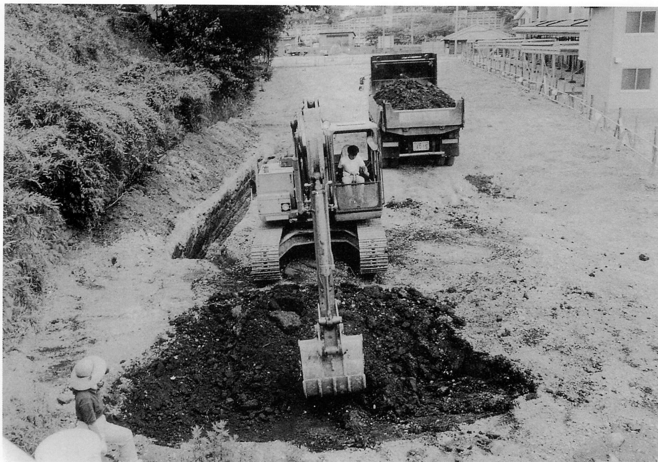
第 8 次調査表土剥ぎ
