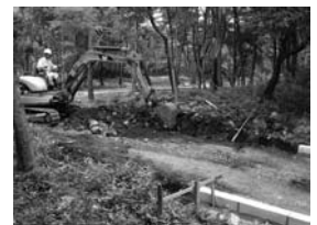
堤防横断面 東側掘削状況
