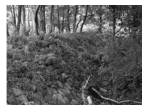
工事箇所周辺の堤防の状況
