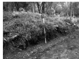
堤防横断面 西側土層
