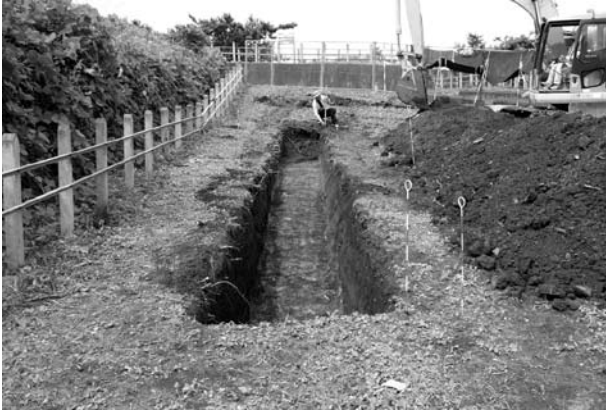
起点地点A-1区4号トレンチ全景
