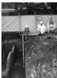
浄化槽撤去状況
