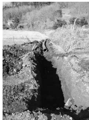
仮設水路造成状況
