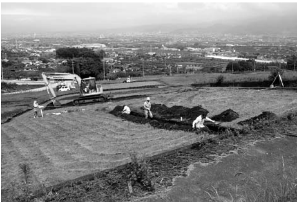
変電所地点A区作業風景
