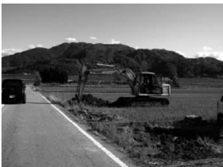
手前から奥へ延びている現道が「河岸お蔵道」
