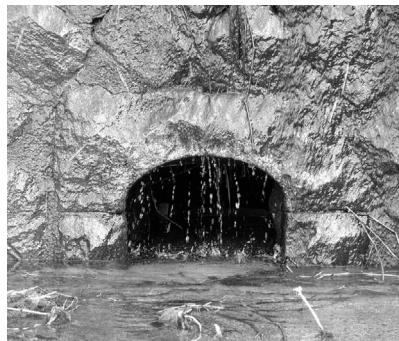
4. 水野田堰堤 水抜き穴
