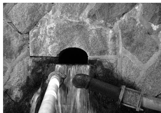
4. 棚小屋澤堰堤 水抜き穴 (2)
