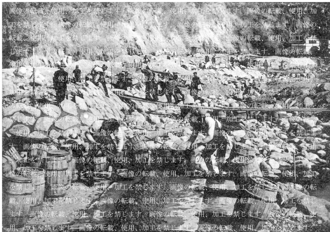
1. 山梨懸東山梨郡勝沼町地先 富士川流域日川筋砂防工事右岸水制第十號頭部築石及混凝土工作業中ノ状況
