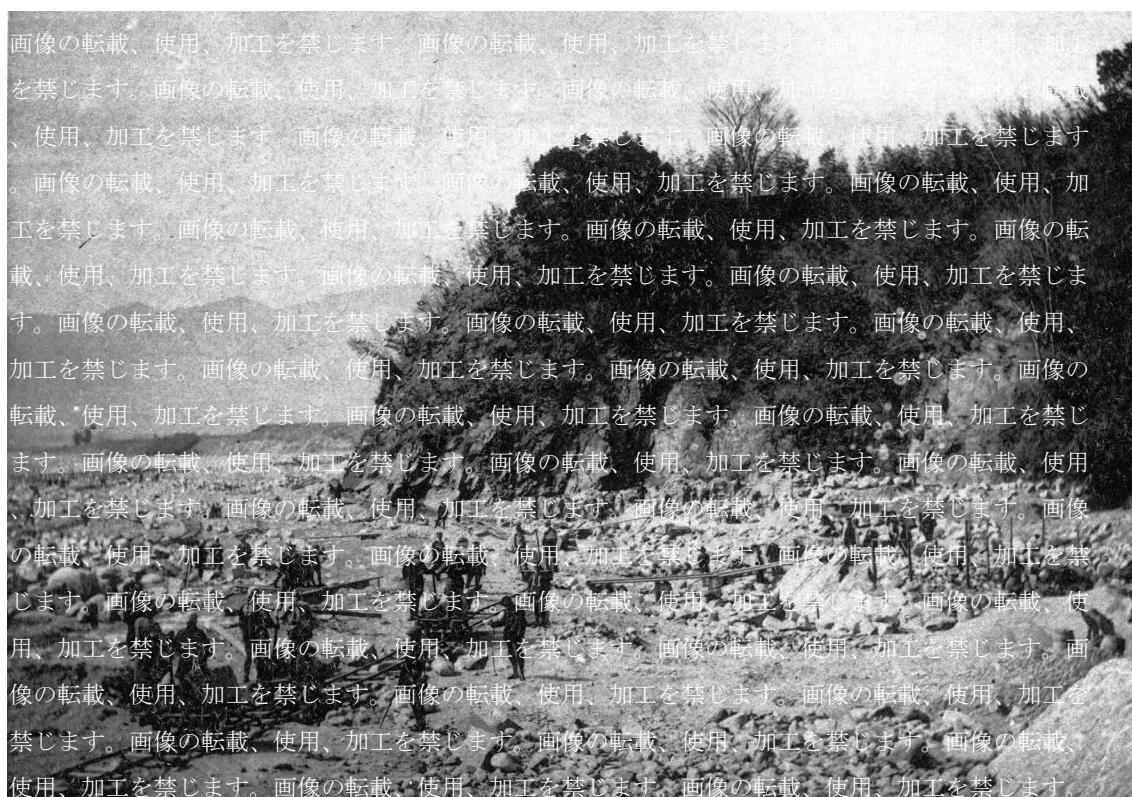
2. 山梨懸東山梨郡勝沼町地先 富士川流域日川筋砂防工事右岸水制第九號頭部築石及混凝土施工中ノ状況
