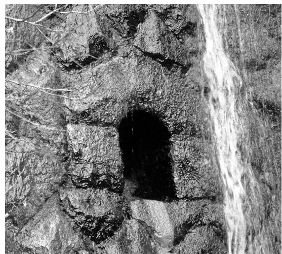
3. 門井澤堰堤 水抜き穴
