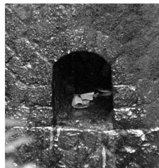
3. 横吹堰堤 水抜き穴 (右: 小、左: 大)
