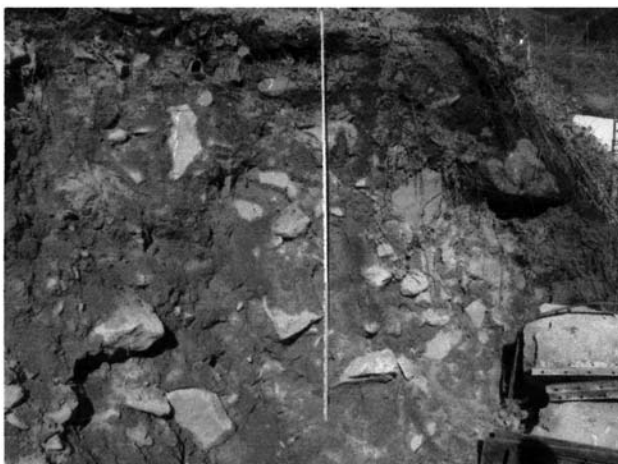
堰堤部分掘削状況
