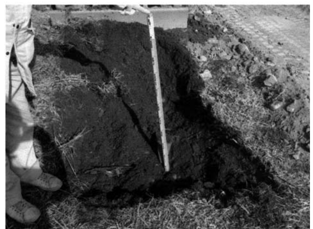
農道部分掘削状況
