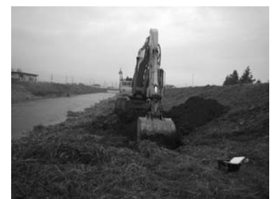
掘削作業風景
