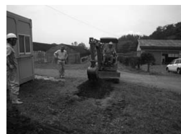
試掘トレンチ掘削状況
