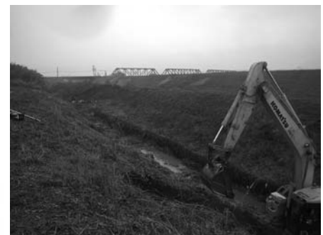
掘削作業風景
