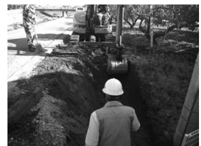
掘削作業風景
