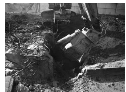
基礎撤去状況
