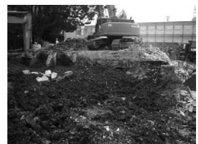
基礎下部確認状況
