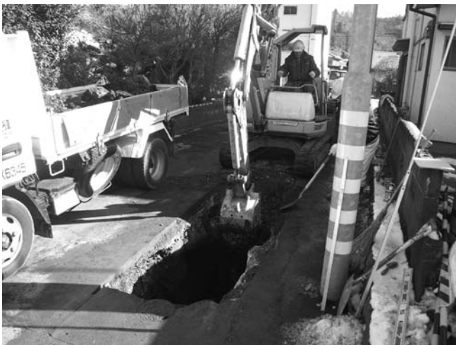
A 地点掘削状況
