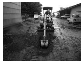
試掘トレンチ掘削状況
