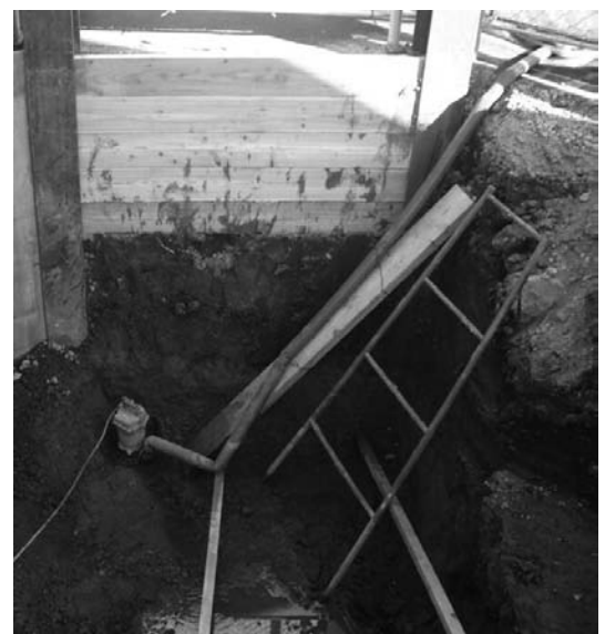
土層推積状況
