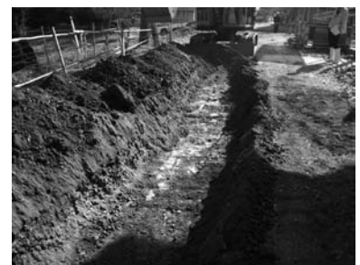
掘削トレンチ確認状況
