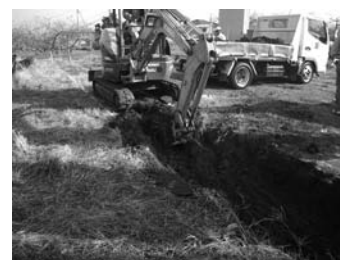
外柵工事掘削状況
