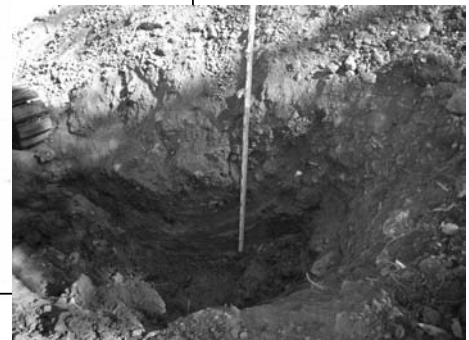
土層断面確認状況
