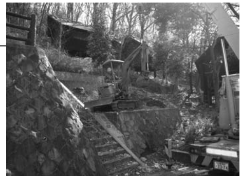
基礎撤去掘前状況
