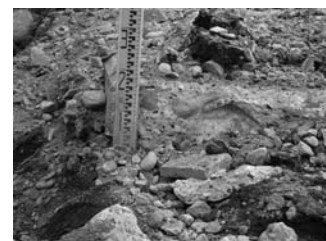
コンクリート基礎断面
