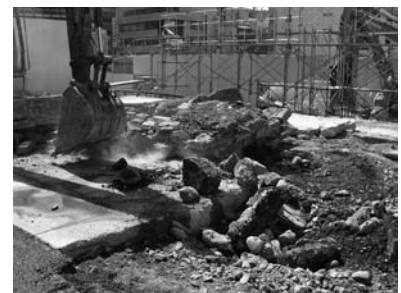
コンクリート土間撤去状況
