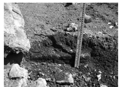
土間下基礎確認状況
