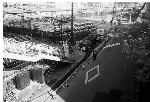
第25-2 左の写真はA地点、B地点の掘削状況
