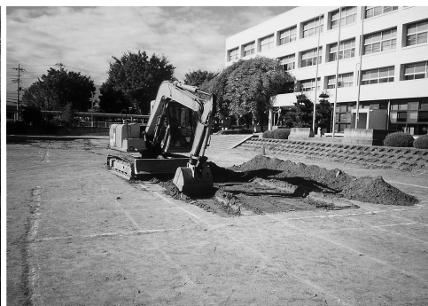
4号試掘溝掘削
