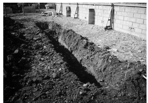
3号試掘溝の状況
