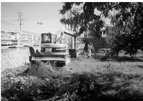
1号試掘溝の掘削
