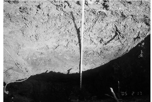
1号試掘溝の状況
