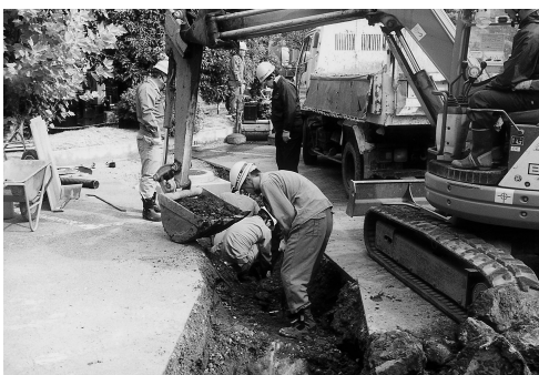
第24-2 県庁舎集中化改修電気設備工事事業
