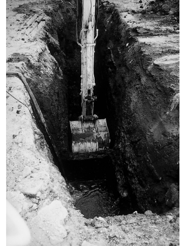
5号試掘溝の状況
