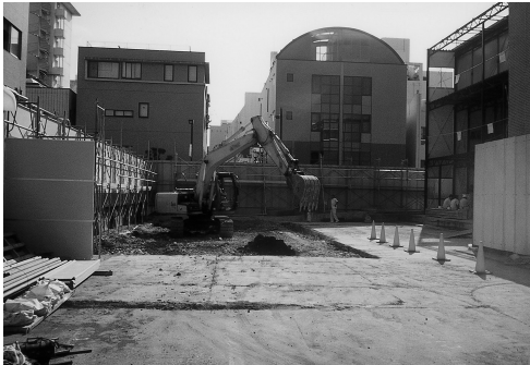
第22-2 甲府地方裁判所仮設庁舎建設事業
