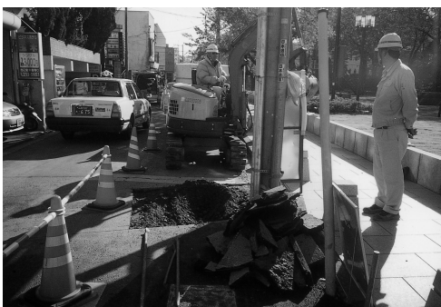
第25-2 国道20号外光ケーブル敷設工事事業
