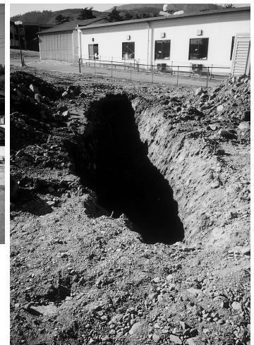
1号溝の完掘状況
