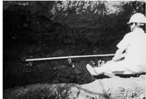
第22-2 杭出土状況
