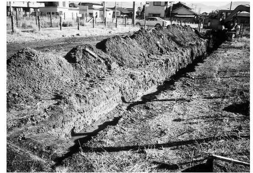
5号試掘溝 (西から撮影)
