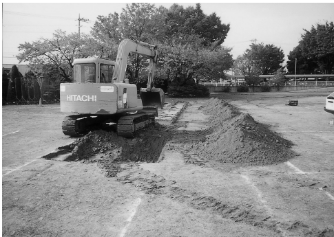
2号試掘溝掘削
