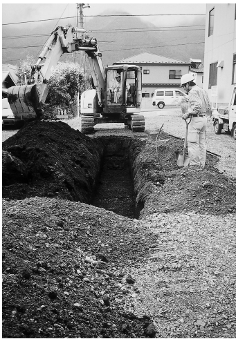
1号試掘溝調査状況
