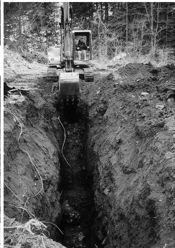
2号試掘溝の状況
