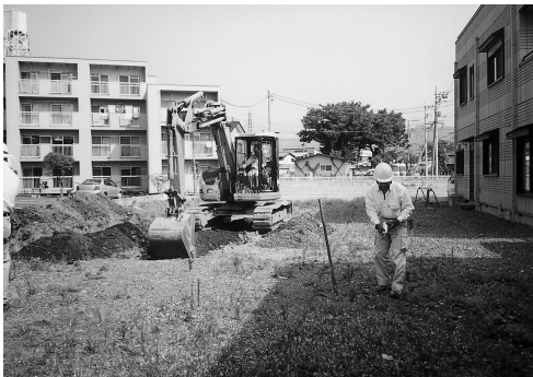
1号試掘溝の掘削状況
