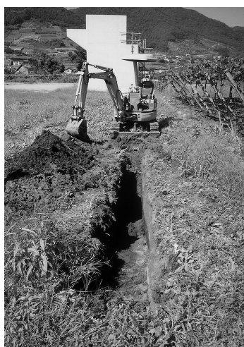
2号試掘溝 (後ろは西関東道路の橋脚)
