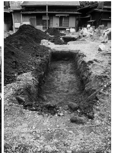
5号試掘溝の状況
