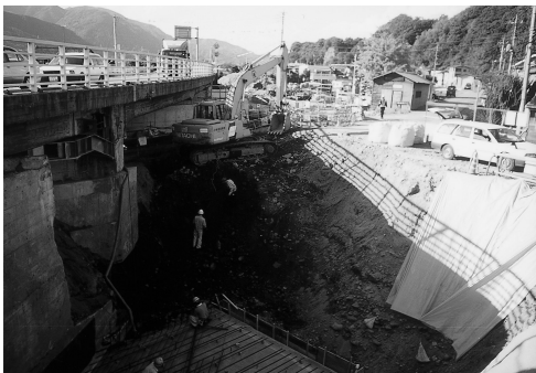
第23-2 国道20号観音橋拡幅工事事業
