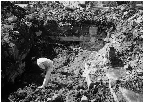
2号試掘溝の状況
