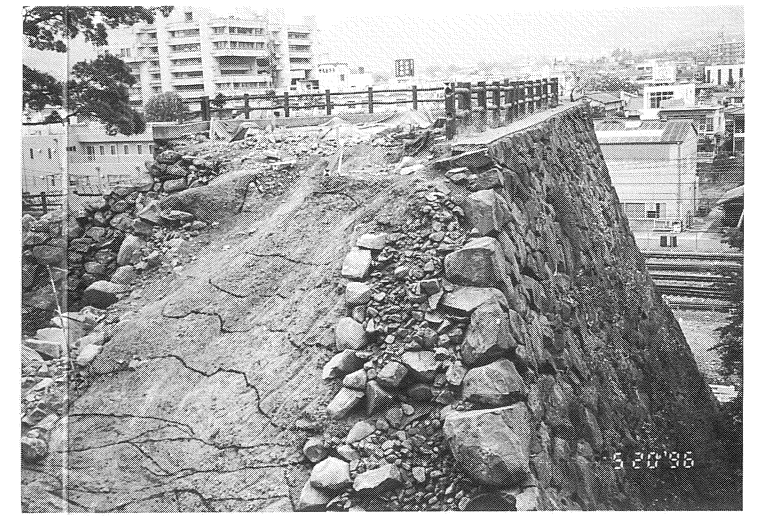
A. 櫓台東面石垣断面・裏盛土
