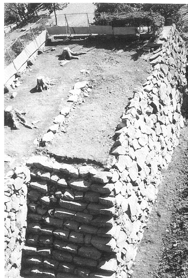
第16図 腰石垣上礎石検出状況
