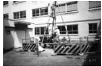
ボーリング調査状況
