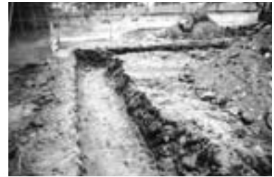
基礎掘削状況
