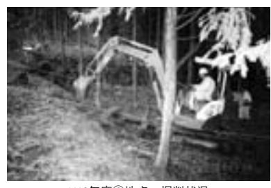
H16年度②地点 掘削状況
