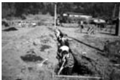
2号トレンチ 作業風景
