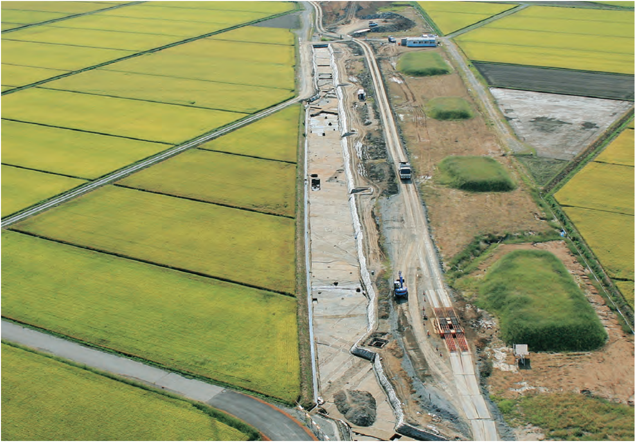
F区完掘状況（北東から）
