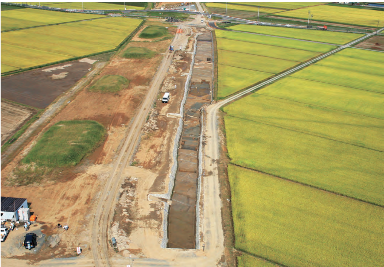
F区完掘状況（南西から）
