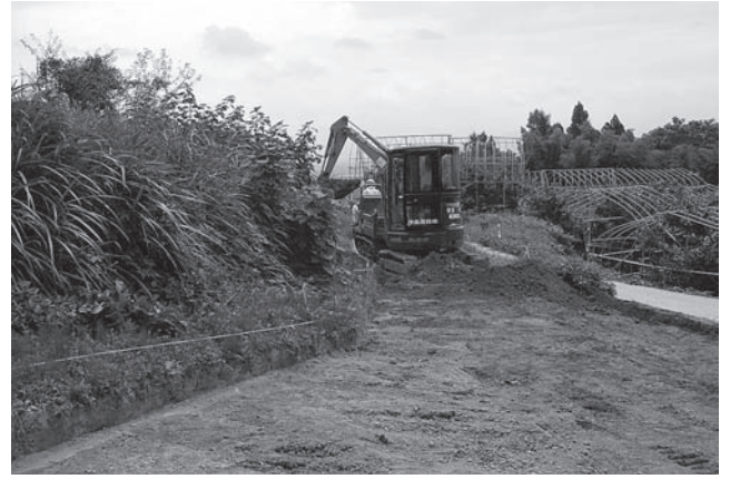
A区表土除去 (2007.08.21)
