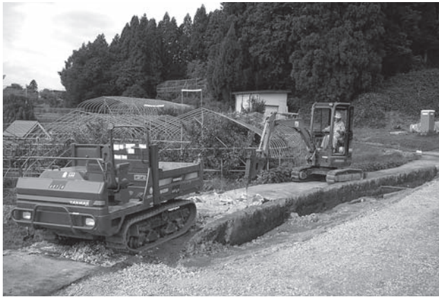
A区農道付け替え工事 (2007.09.25)
