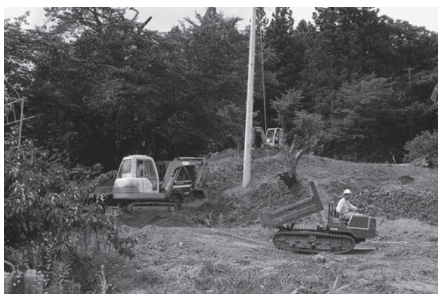
M区表土除去 (2008.07.10)
