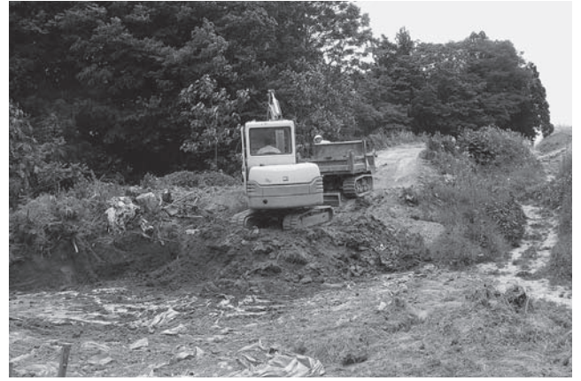
E区表土除去 (2008.06.13)
