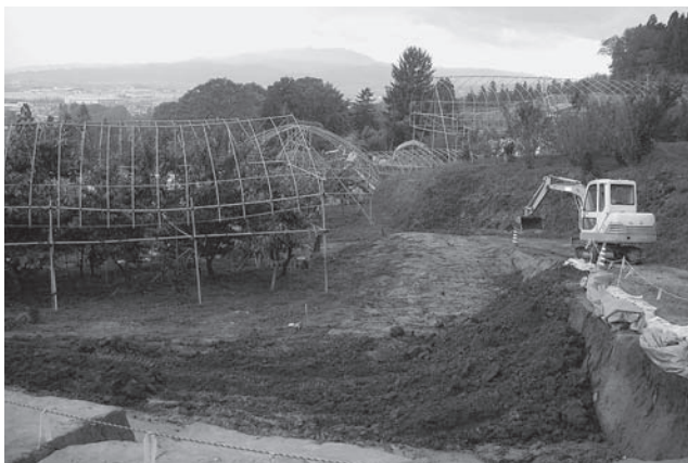
A区南半部埋戻し (2007.11.01)
