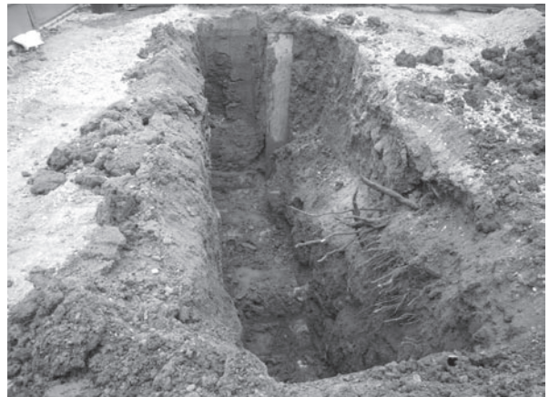
6. 山留工に伴う掘削状況
