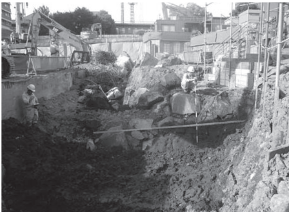
9. 一の堀南部石垣出土状況
