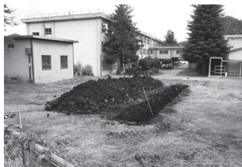
B地点トレンチ掘削状況
