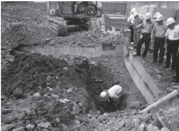
立会調査第1地点 調査風景
