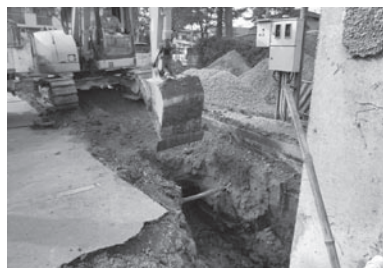
第1回目 作業状況
