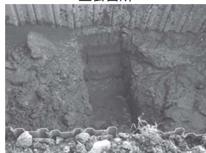
河床掘削確認状況
