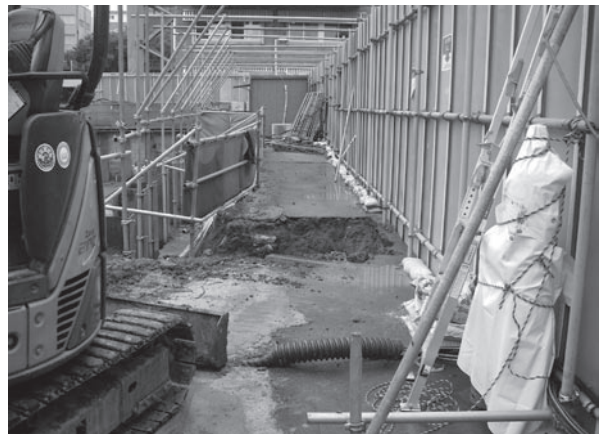
10. 仮設ゲート基礎掘削状況
