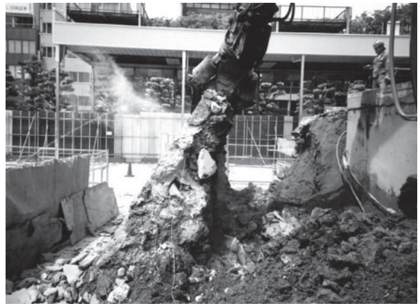
4. オイルタンク撤去状況
