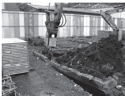
基礎抜取作業
