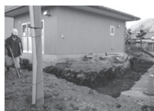
第2～4地点掘削状況
