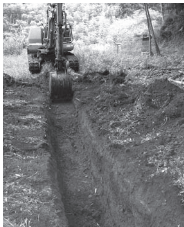
1号トレンチ掘削風景
