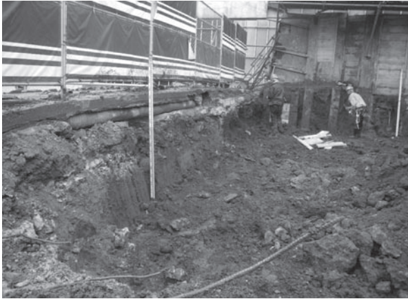
7. オイルタンク周辺掘削状況
