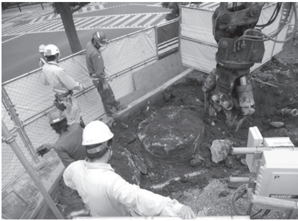
3. 旧歩道橋基礎撤去状況
