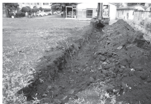
A地点トレンチ掘削状況
