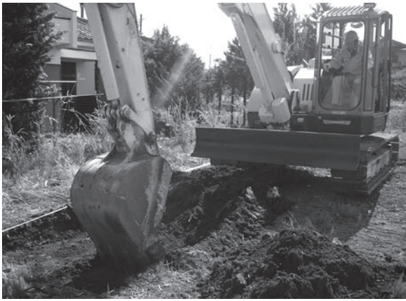
1号トレンチ掘削状況
