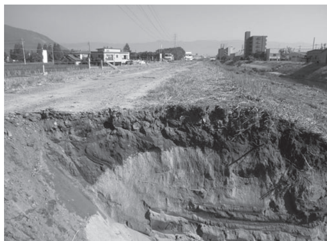
第2地点の土層断面写真
