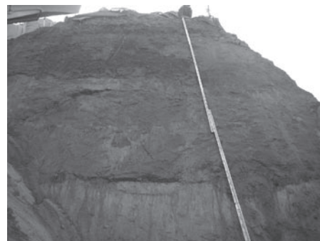
断面確認状況
