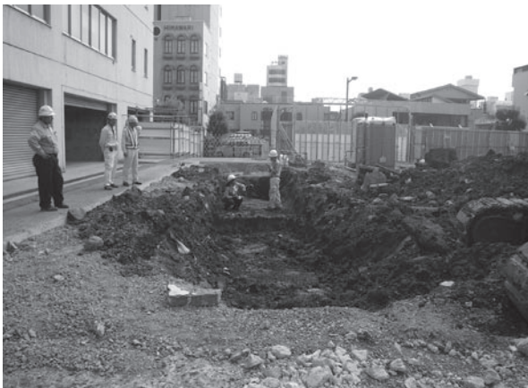
試掘調査状況写真 (左：西側から撮影)
