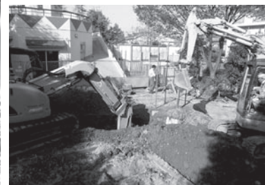
第2回目 作業状況
