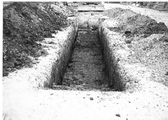
調査状況 (南から)
