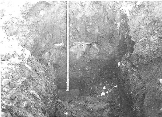
山形西高敷地内遺跡第2 体育館基礎解体 立会トレンチ土層（南から）
