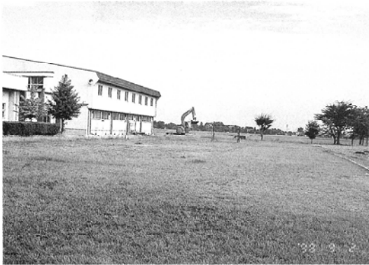
谷柏遺跡調査区近景（南から）
