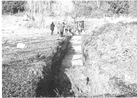
TT2 調査状況 (東から)
