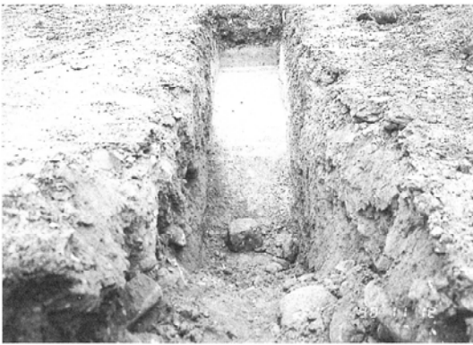
T2 調査状況（北から）
