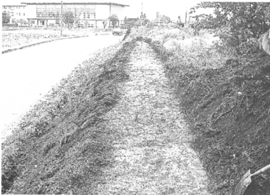
T1 遺構検出状況（南から）
