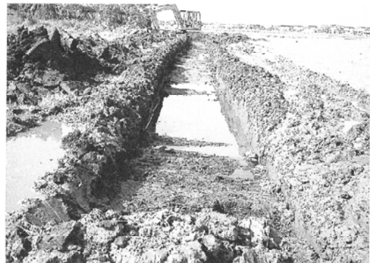
調査状況 (南から)
