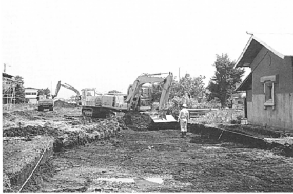
3区重機による表土除去作業(西から)
