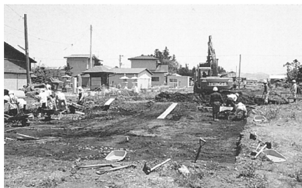
重機粗掘状況(西から)
