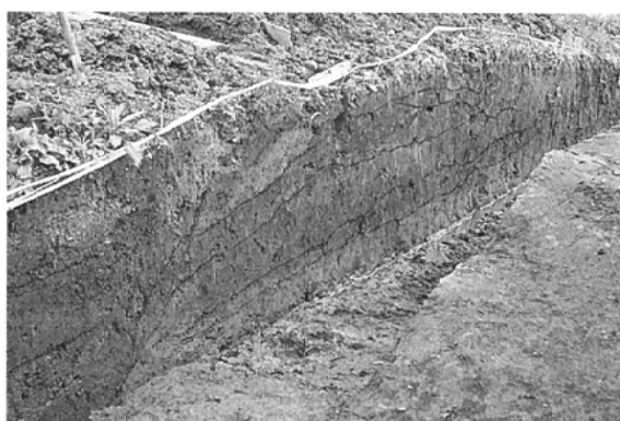
S D 109調査状況 (南から)
