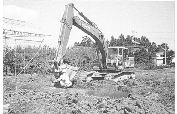
鋼管埋設作業(南西から)
