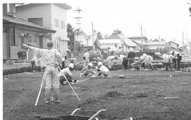
グリッド杭打状況(東から)
