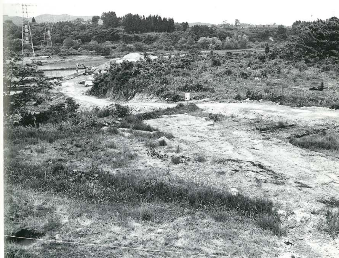
調査前全景（南から）
