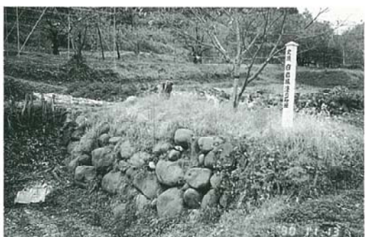
白岩館跡濠の石垣（南東から）
