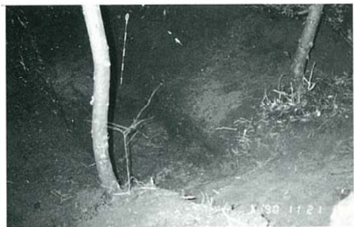
館の内空堀試掘状況（東から）
