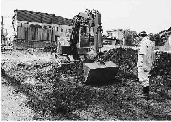
重機稼動状況
