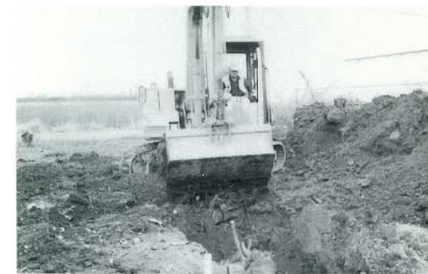
T1土埋め戻し作業状況（南西から）
