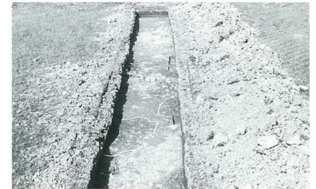
T3調査状況（西から）
