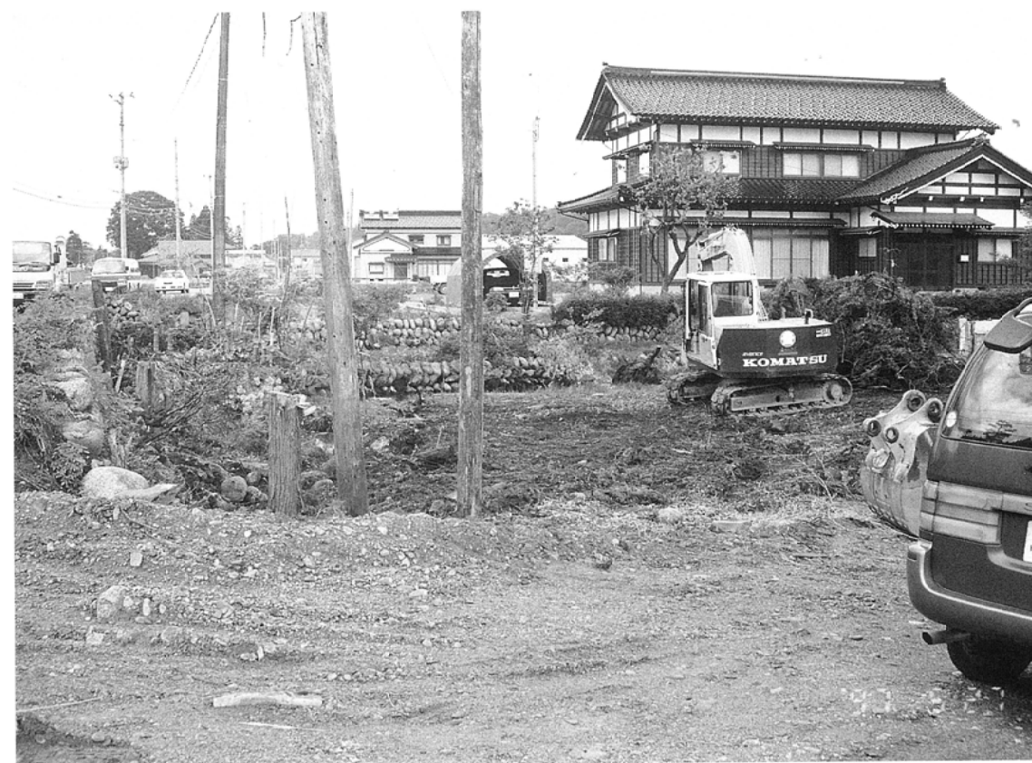
調査区近景 (南から)
