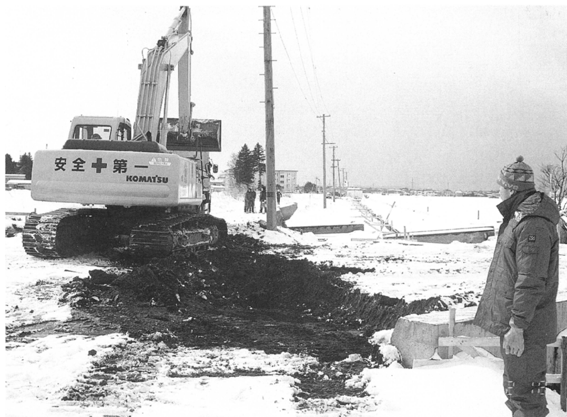
調査区近景（北から）
