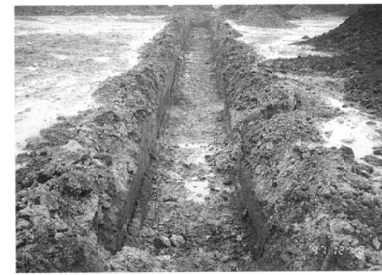
T10-2 調査状況 (南から)
