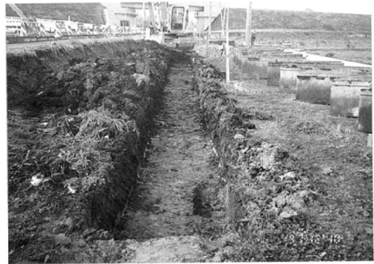
T I 調査状況（東から）
