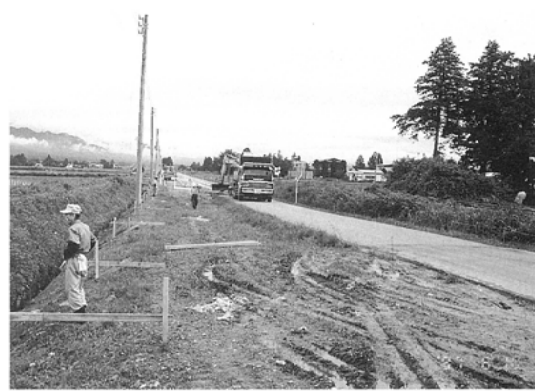
調査区近景 (南から)
