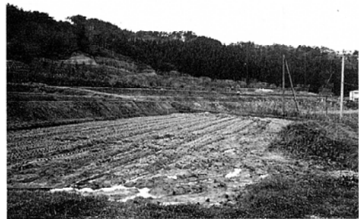
稲沢南遺跡遠景（北東から）
