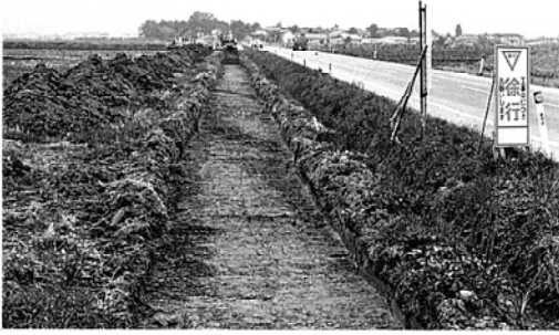
T-5 トレンチ全景 (東から)
