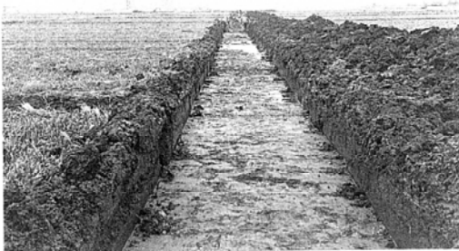
B トレンチ（西から）
