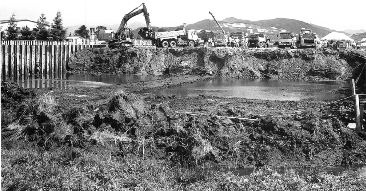
掘削・土取り
