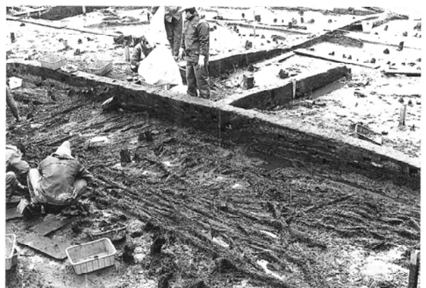
住居跡根太検出作業 (ST-11)
