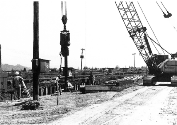
鉄鋼矢板打ち込み作業
