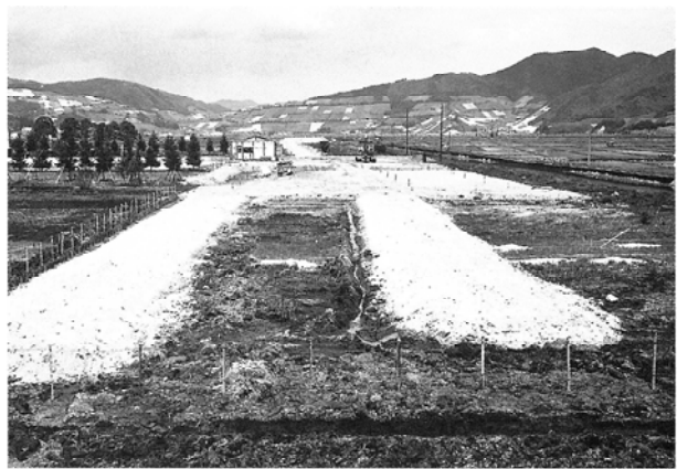
矢板打ち込み用仮設道路
