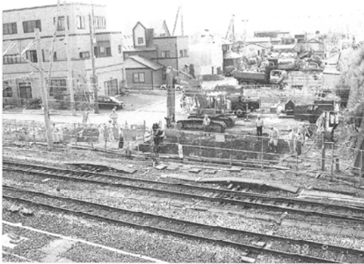
西1T 調査区近景（東北東から）
