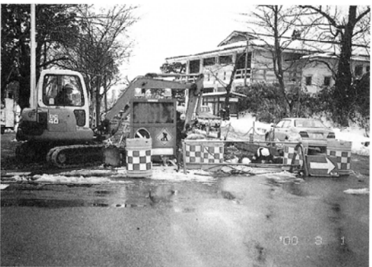
取水管等立会調査状況（西から）
