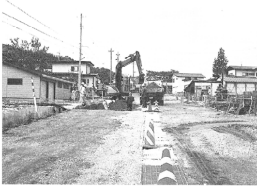
調査区近景（北から）
