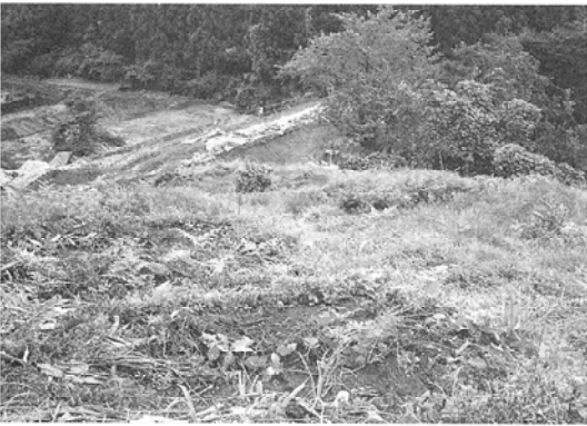
水沢館跡隣接地工事状況（西から）
