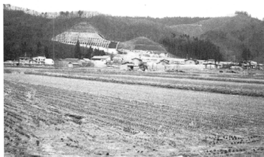
北島遺跡近景 (南西から)
