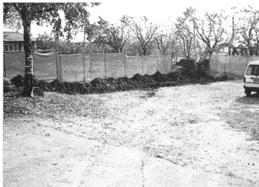
試掘調査状況 (現グランド・北西から)
