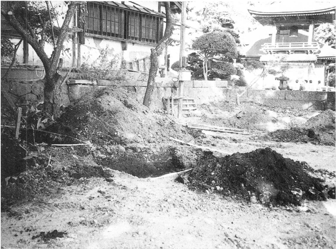
調査区近景（南西から）
