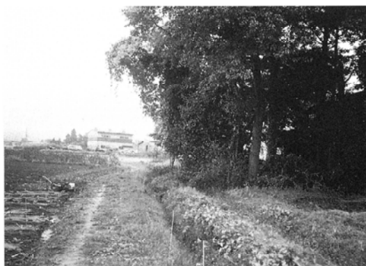
北側土塁・堀跡近景（西から）
