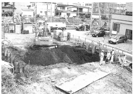
西2T 表土除去状況 (北西から)
