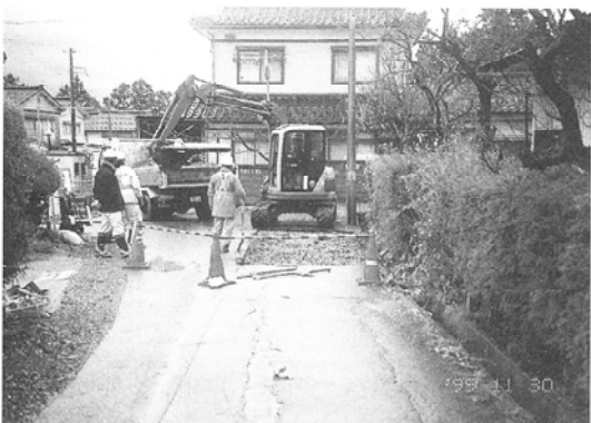
松山城跡立会い調査状況 (南から)
