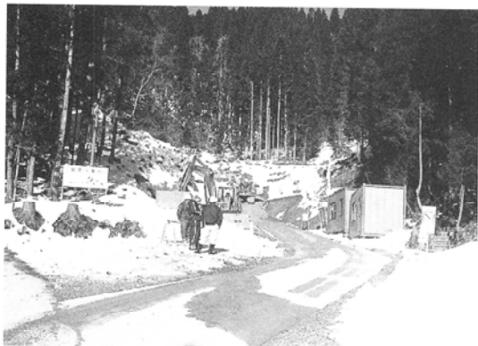
志茂の手館跡工事区域近景（南東から）
