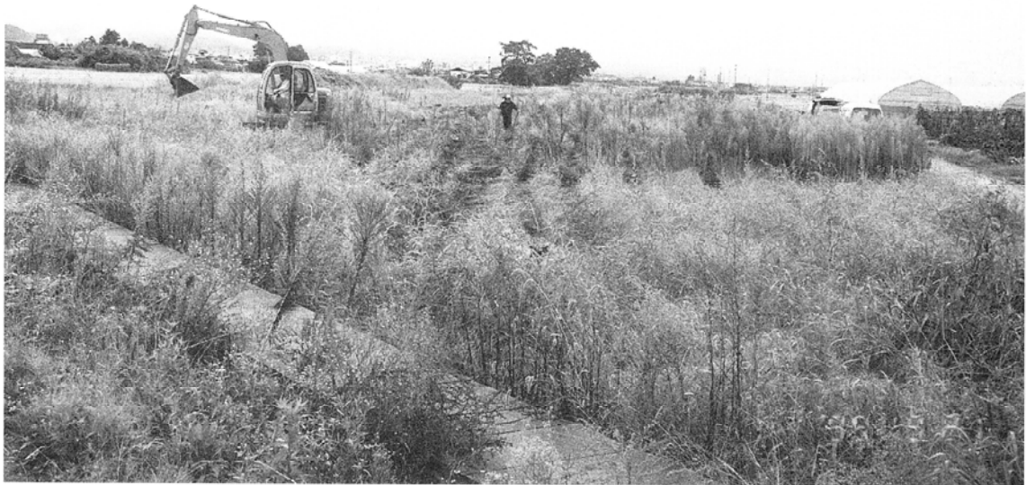
遺跡近景（北から）
