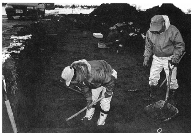
市道立会調査 作業状況 西から
