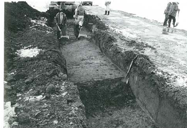
市道立会調査 作業状況 南東から
