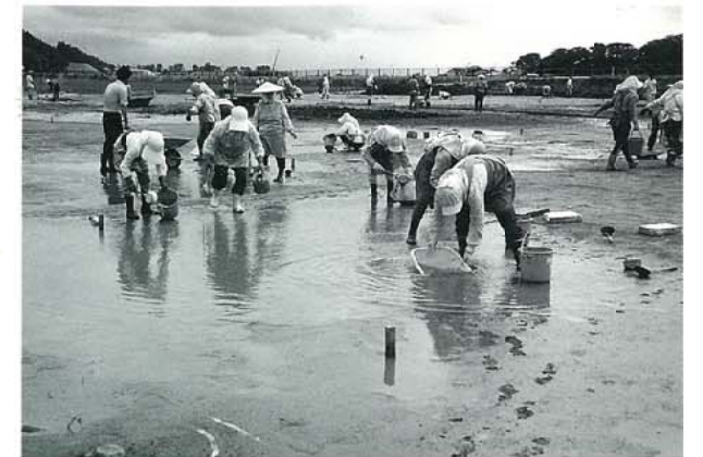
降雨後水汲み作業状況 西から
