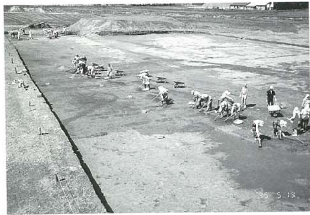
面整理作業状況 北東から
