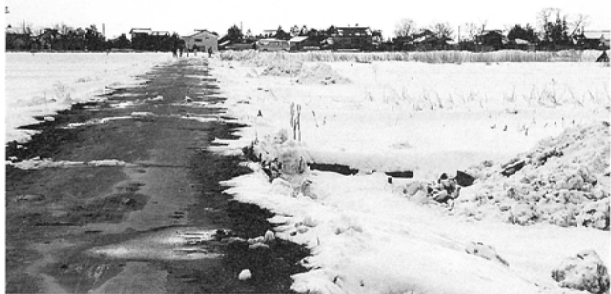
市道立会調査 調査前状況 西から
