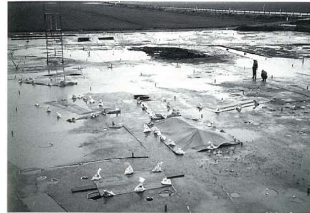
雨天時現場状況 西から
