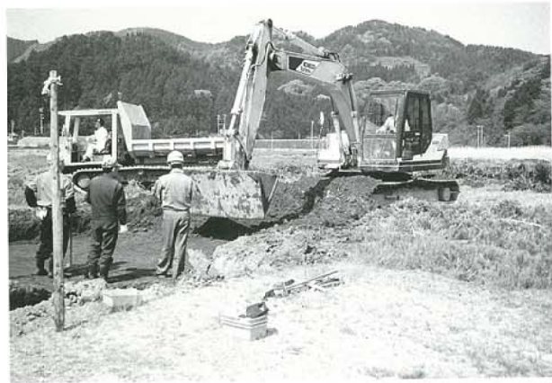
重機による表土除去作業状況 北東から
