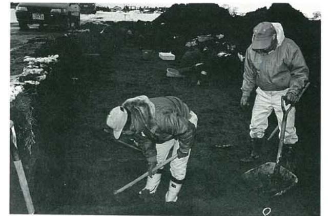
市道立会調査 作業状況 西から
