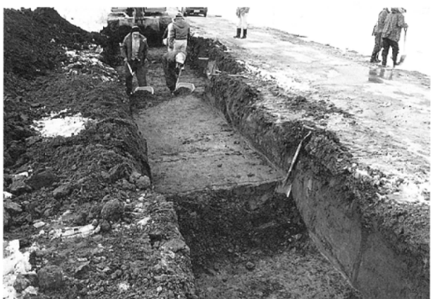
市道立会調査 作業状況 南東から
