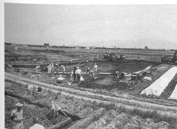
A地区表土除去・面整理状況 (南西から)
