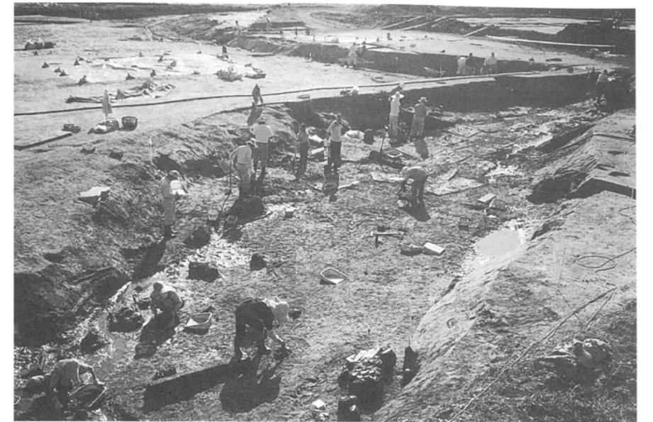
SG213調査状況 (北東から)
