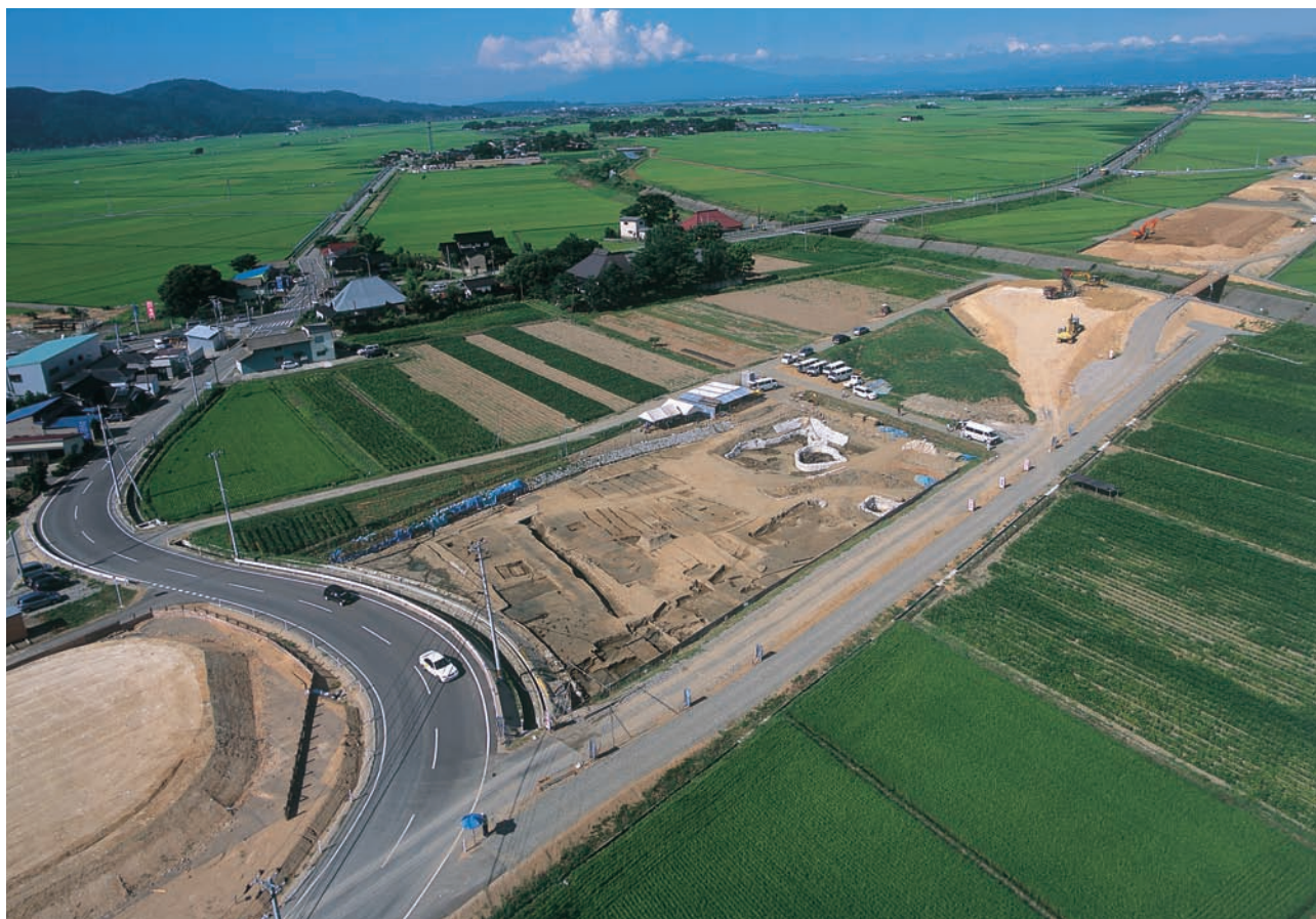
第3次調査区全景（南西より）
