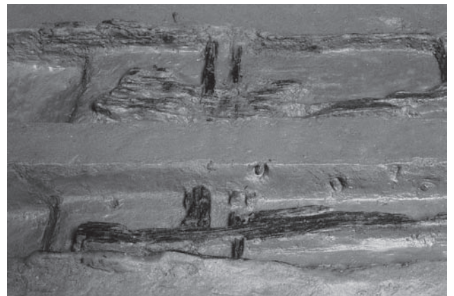
SH 81 木組状況
