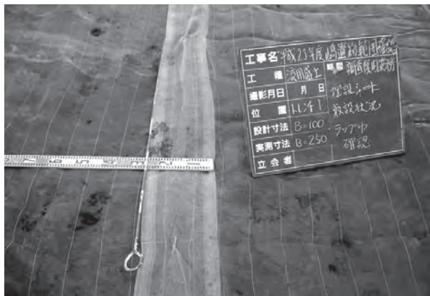
土壌分離シートの敷設
