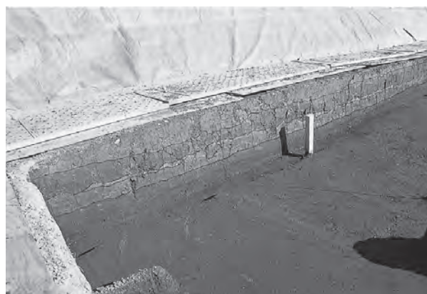
トレンチ5 東壁断面 (北西から)
