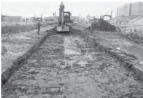
トレンチ3 表土除去状況（北から）
