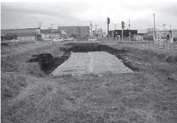
土壌分離シート敷設状況
