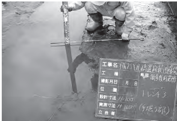
手掘り部 深さ確認
