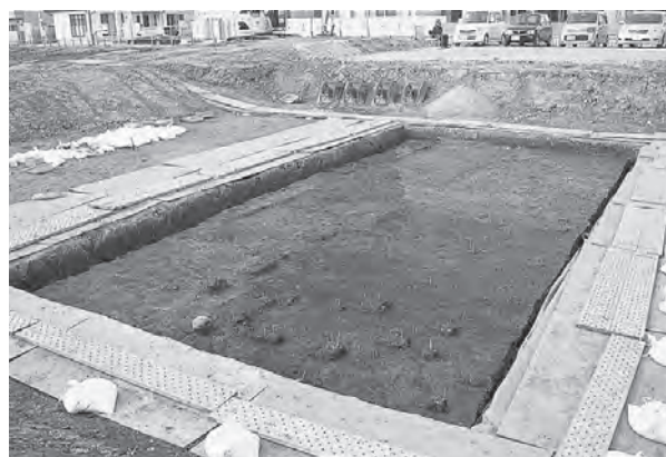
トレンチ5 SD1検出状況 (南から)
