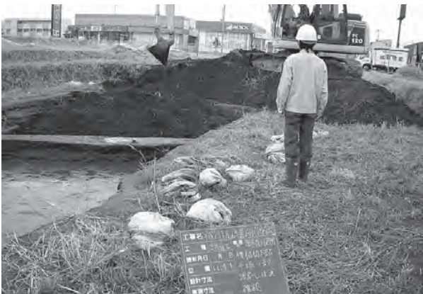
トレンチ1 手掘り高さまでの埋戻し
