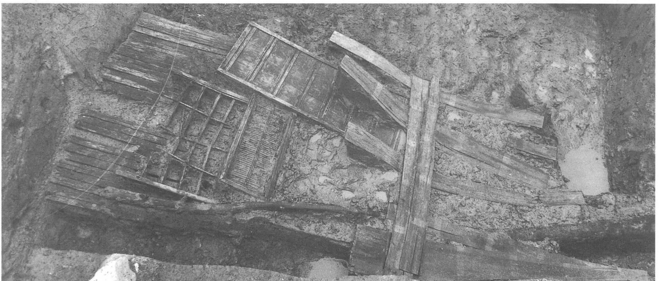
第3面 流路内建具検出状況（北から）
