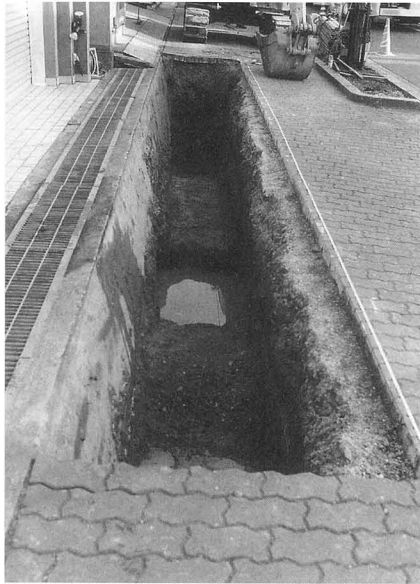
5T (北西から)
