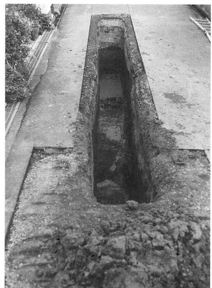
10T (北西から)
