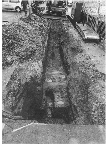
1T 全景 (北西から)
