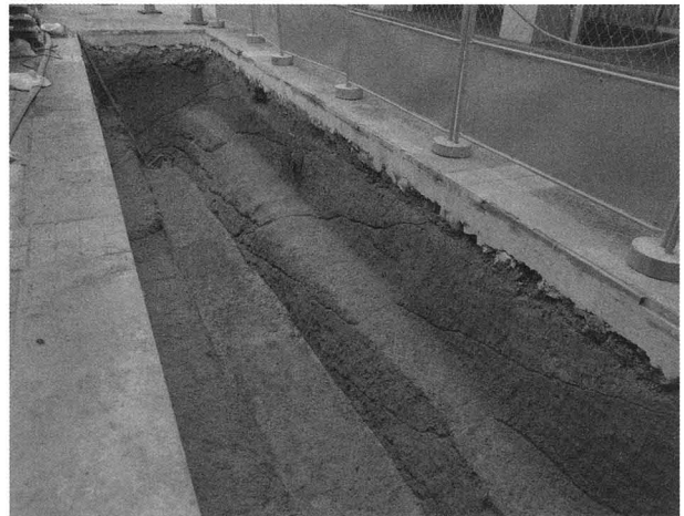
図32 Aトレンチ (西より)
