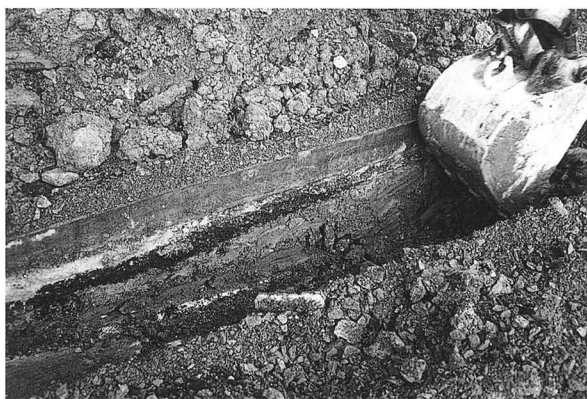
図12 配管工事立会調査（地点1）
