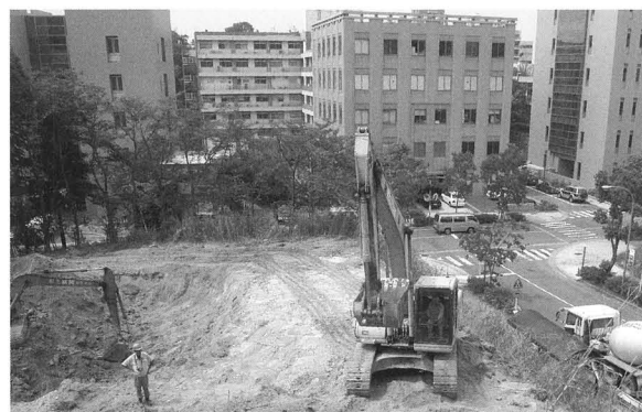
図33 超高圧電顕センター研究棟建設工事立会調査
