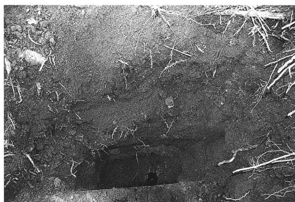
図14 中央変電所ケーブル埋設工事立会調査（地点3）
