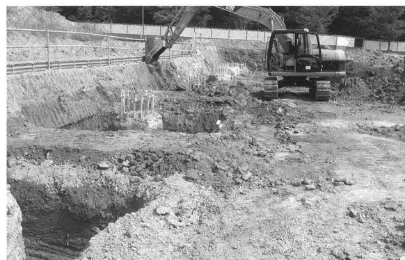
図34 情報系総合研究棟新営工事その他工事立会調査
