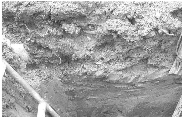
図29 理学部校舎改修その他機械設備工事立会調査（地点31）
