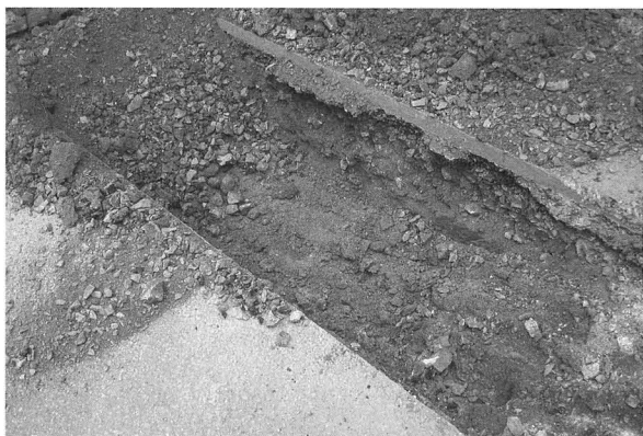
図18 明道館増設コンセント工事立会調査 (地点13)
