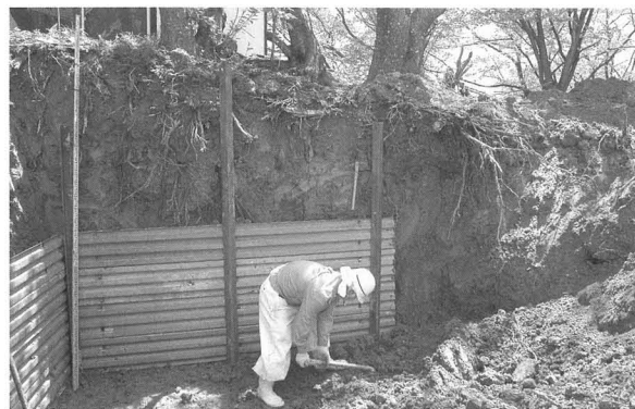
図24 特高変電所新設に伴う埋蔵文化財立会調査（地点25）
