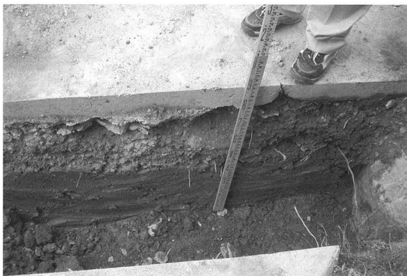
図23 危険物薬品庫新鋭機械設備配管工事立会調査（地点22）
