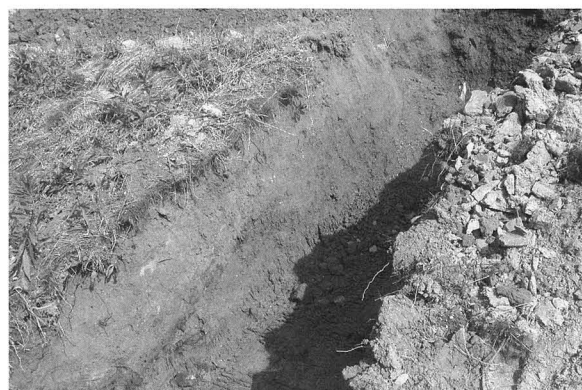
図21 先端科学技術センター・インキュベーション施設立会調査
