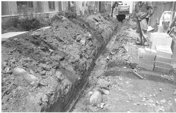
図28 基礎工学部本館校舎改修その他電気設備工事立会（2）調査（地点29）
