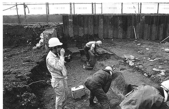
図35 中之島（旧医学部跡地）土壌プラント設置立会調査
