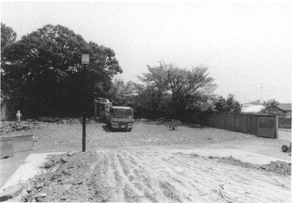
3 調査風景 2 (北から)
