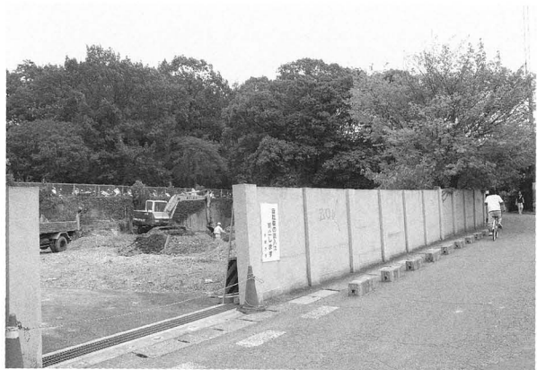
2 調査風景 1 (整備前の阪大坂から)
