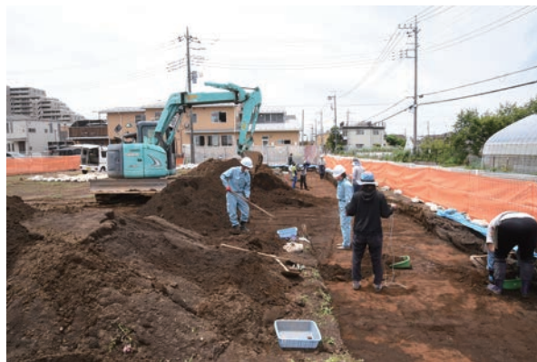
2. 表土剥ぎ（北東から）
