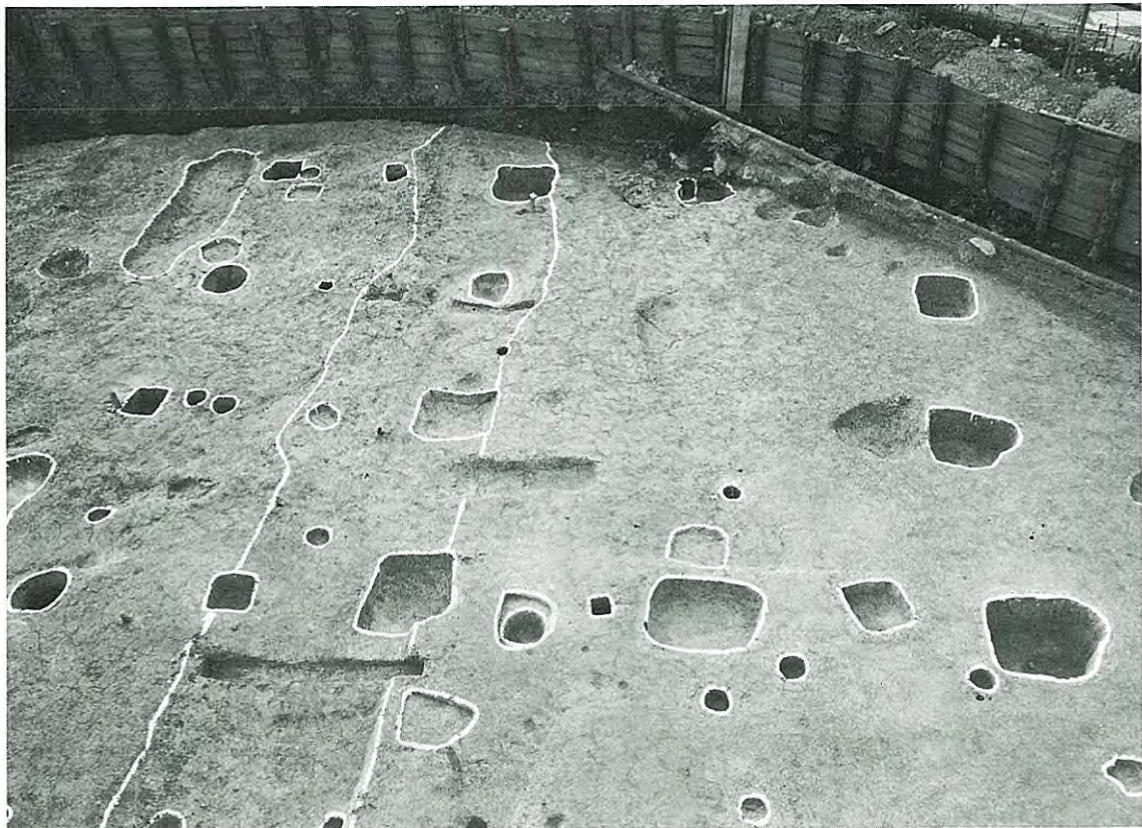
建物A-8 (東より)
