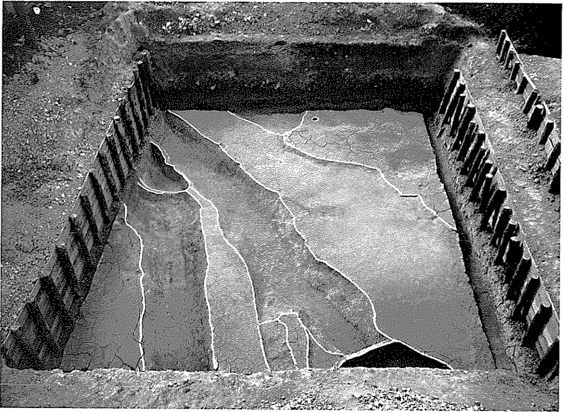
C-9調査区（北東より）
