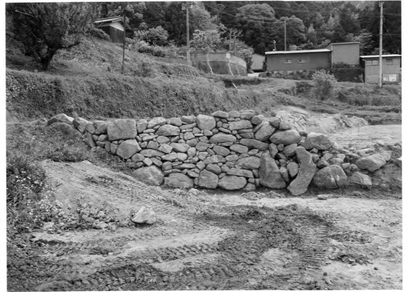
42SX025 検出状況 (西から)
