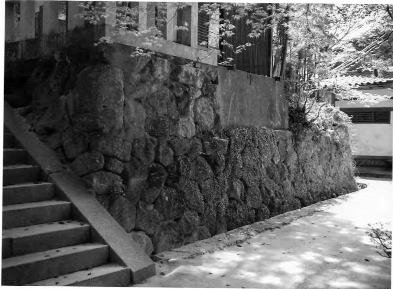
竈門神社本殿正面石垣（北から）
