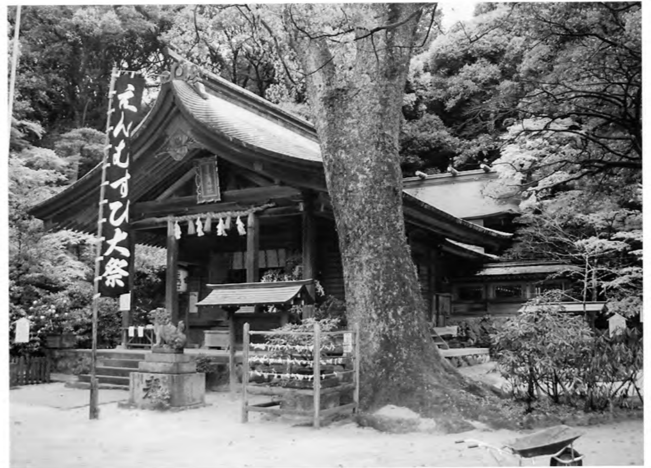
竈門神社拝殿と本殿 (南西から)
